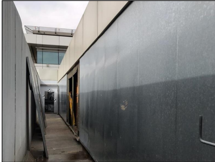
Figura 8.3 Sector de reemplazo de panel acústico
