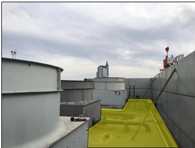
Figura 8.4 Sector de reemplazo de panel acústico en cubierta
