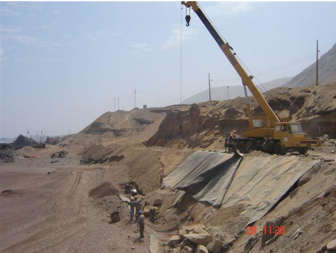
Inicio del enrocado del muro protección al pie del talud de los antiguos rípios. La foto da cuenta de la excavación de 1,5 m aproximados bajo el nivel de la playa para colocar rocas de gran tamaño en la base. (2005)
