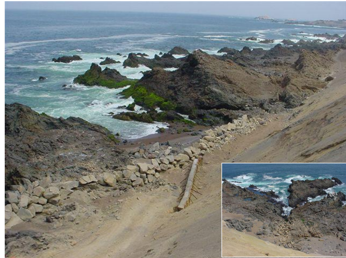
Vista superior de enrocado adicional que se construyeron, detrás de los enrocados en las entradas de mar. En costado izquierdo enrocado en entradas de mar (2005)
