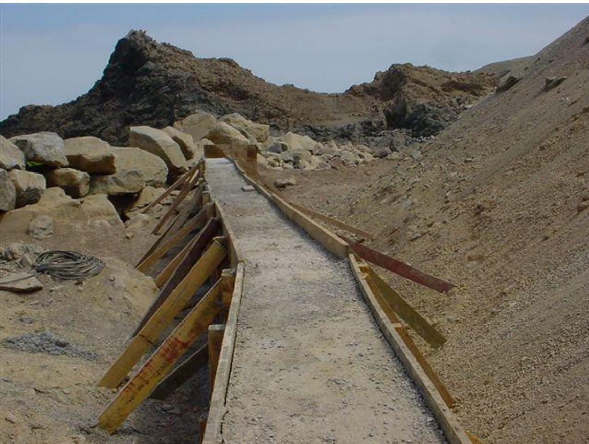
Registro gráfico de la construcción del nuevo muro de contención, construido sobre el antiguo (2005)
