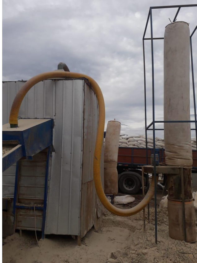
CASETA DE ENCAPSULAMIENTO MOLINO REFINADOR Nº 2
