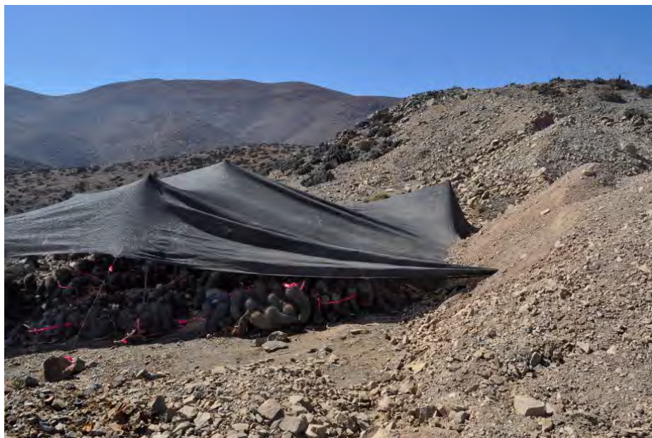
Fotografía 16: Estado del sombreadero T11 una vez reparado, utilizando el acopio para tensar la malla raschel.
