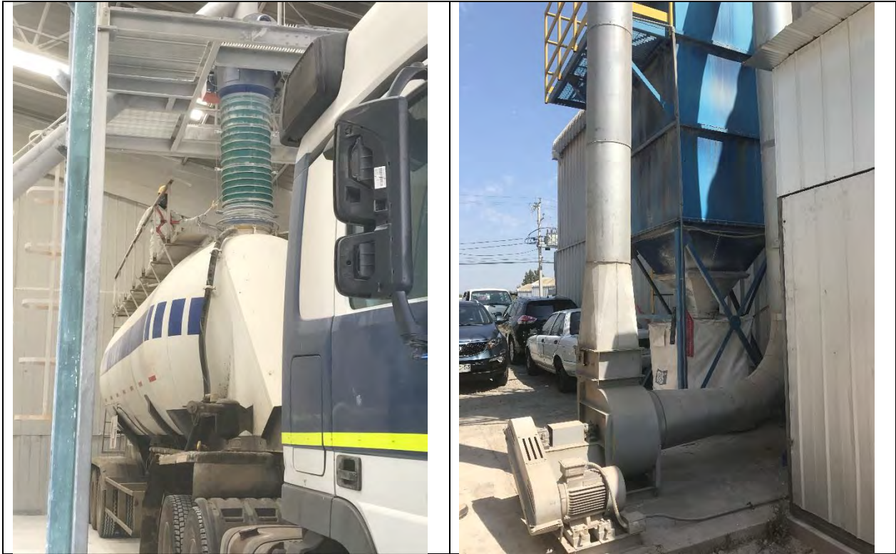
Figura 3-3 Izq: Supervisión de carga de camión. Der: Sistema de extracción.
