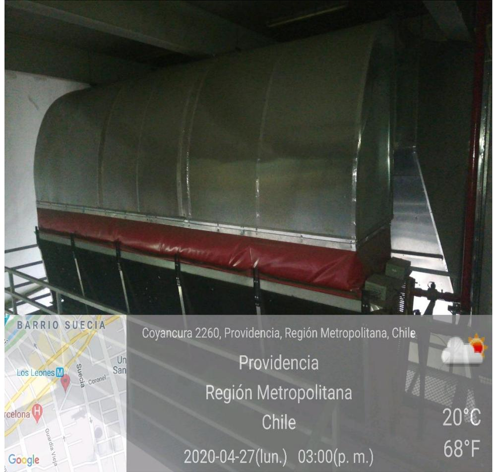
Fotografía 2 – Equipo Condensador Insonorizado (Georreferenciada).
