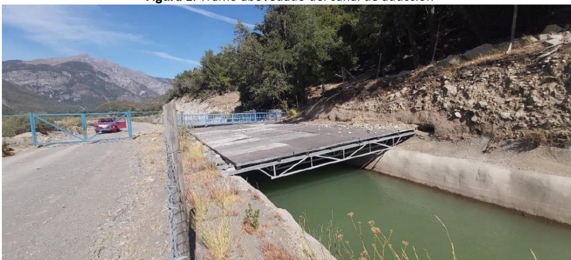
Figura 1. Tramo abovedado del canal de aducción
