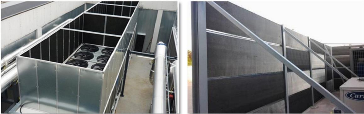
**Figura 14.-** Imagen referencial de paneles acústicos utilizados en cierre de equipos de clima.
