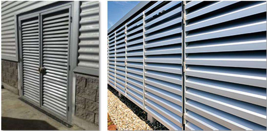
**Figura 16.-** Imagen referencial para silenciador tipo Louver.
