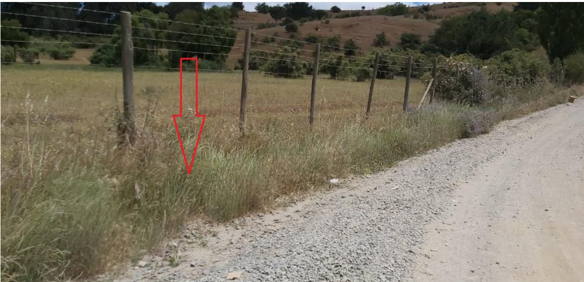
Figura 11: Canalización aguas lluvia. Fuente: DSS.
