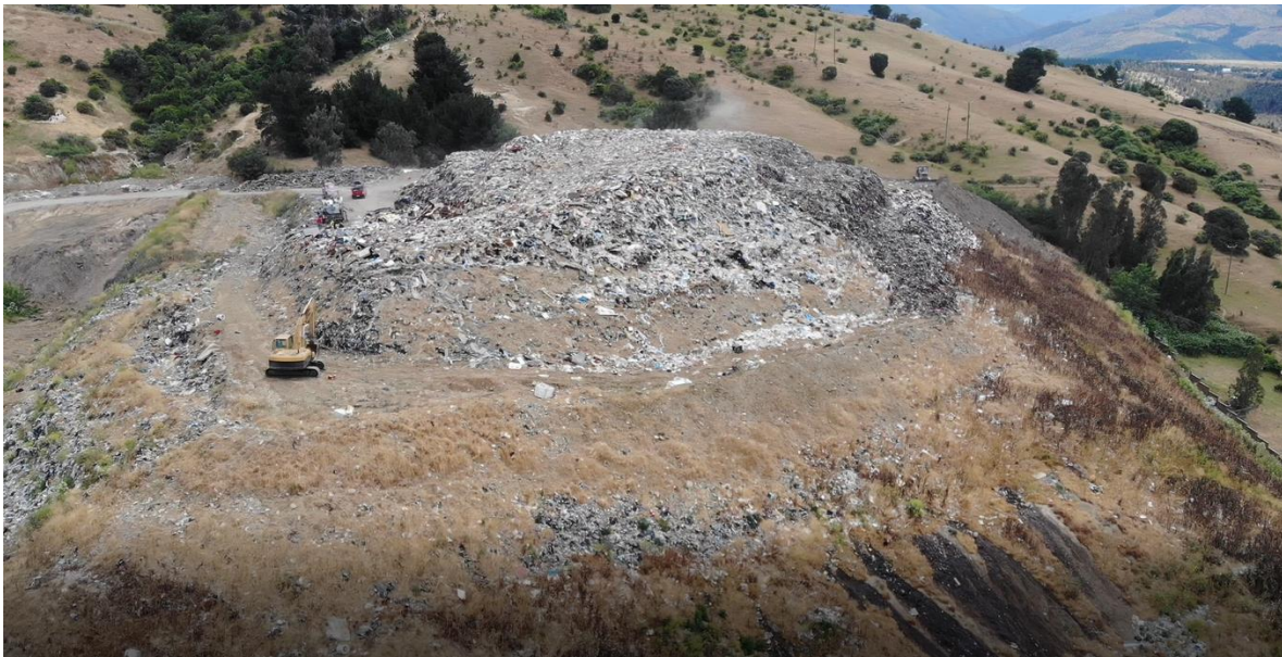
Figura 5: Zona Acopio Vertedero. Fuente: DSS.
