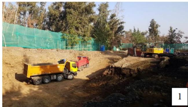
2- En la siguiente etapa de fundaciones, el hallazgo de rocas, significó contratar un servicio especial de fracturamiento, consistente en la aplicación de un cemento expansor mediante la perforación con taladros.
