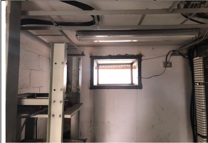
Retiro de equipo ventana
