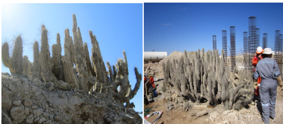
Foto Nº10. Vista de cactus C3 en su estado y ubicación original.
