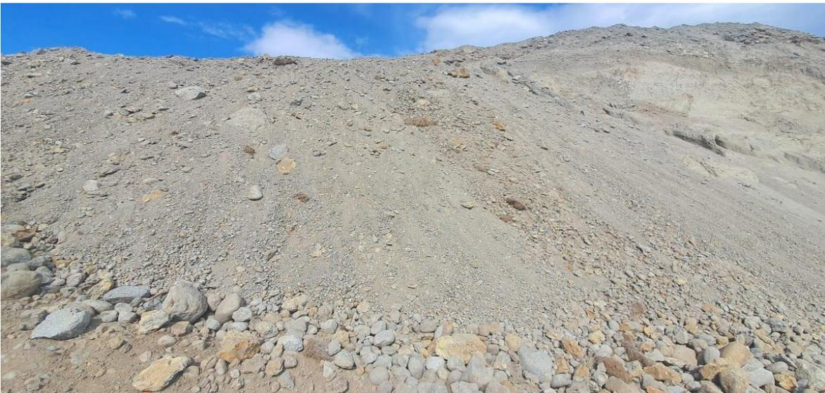
Estas fotografías dejan ver la migración de los finos, que posteriormente se traduce en el desprendimiento del material granular como se observa en la misma fotografía ,al estar este talud expuesto y sin ninguna solución que ayude a la germinación ,el proceso natural puede llevar mucho tiempo, por lo que es recomendable una solución rápida y eficiente ,tal como lo es la contención con gaviones y la manta control de erosión para evitar la erosión y favorecer el crecimiento de vegetación.
