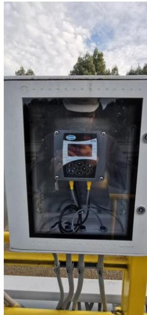
**Imagen 25.** Sensor Solidos Suspendidos Totales reactor biológico 1, PTAS Llanquihue – Puerto Varas.
