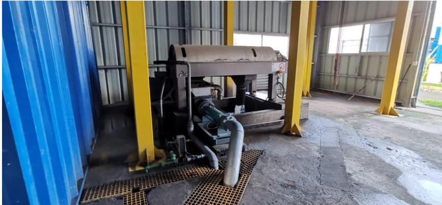
**Imagen 20.** Equipo Decanter de deshidratado de lodos en exceso ALFA LAVAL IDW-40, PTAS.
