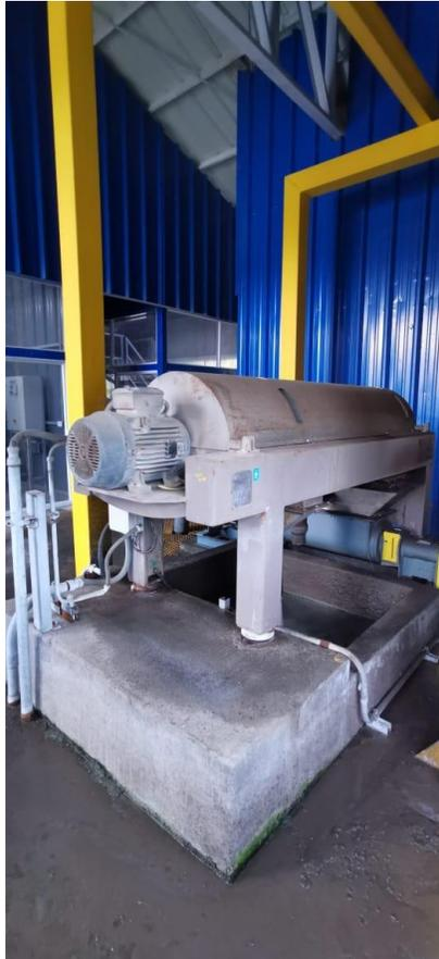
**Imagen 21.** Equipo Decanter de deshidratado de lodos en exceso ALFA LAVAL IDW-40, PTAS.
