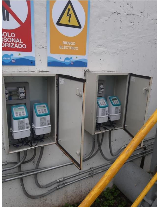
**Imagen 28.** Sensor de medición de caudal de líneas de recirculación de lodo hacia reactores biológicos, PTAS.
