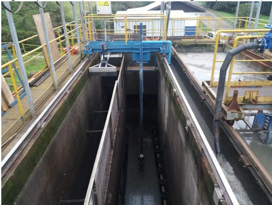
**Imagen 17.** Mantenimiento general de puentes desarenado-desengrasado pretratamiento, PTAS.
