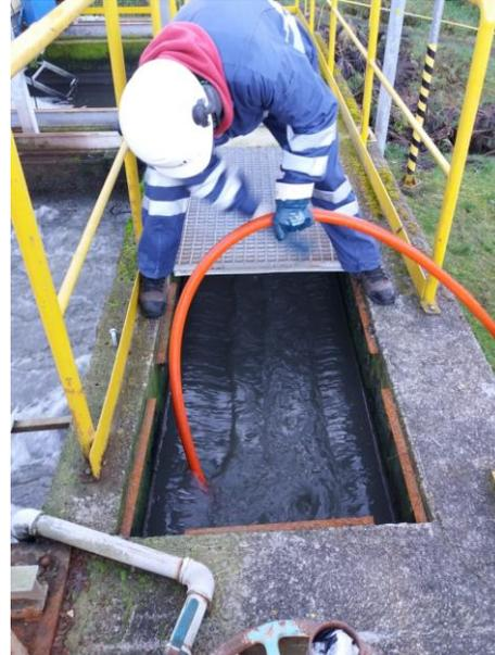
**Imagen 5.** Limpieza de tubería de pretratamiento a cámara de repartición hacia biológicos post construcción de refuerzo, PTAS(11/12/2019).
