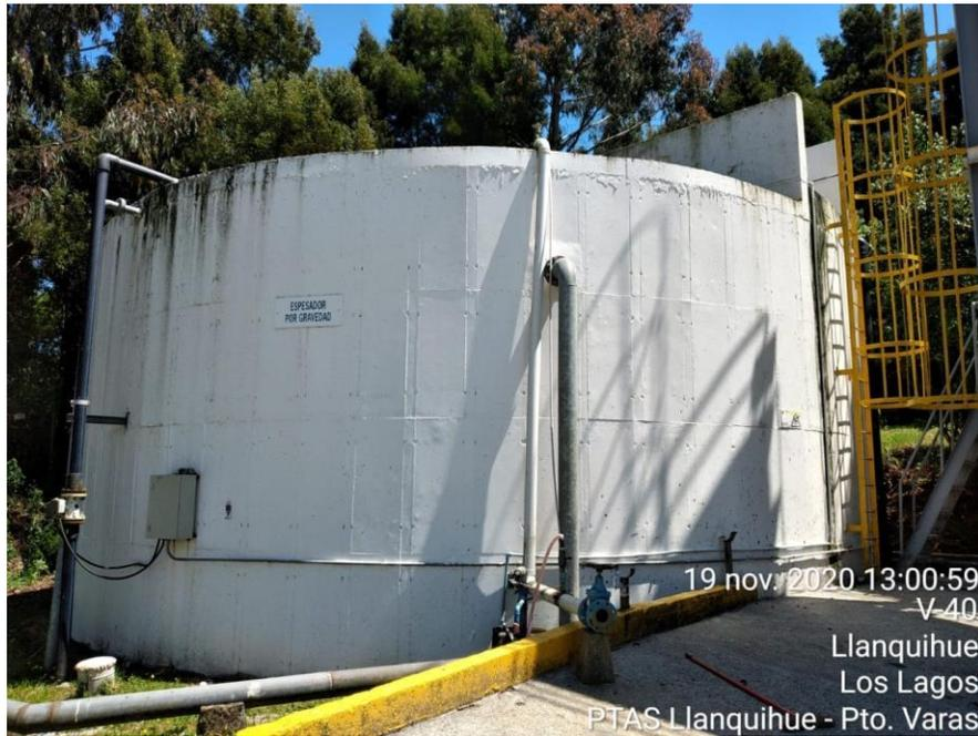
Imagen 12. línea de refuerzo de purga de lodos en exceso, PTAS.
