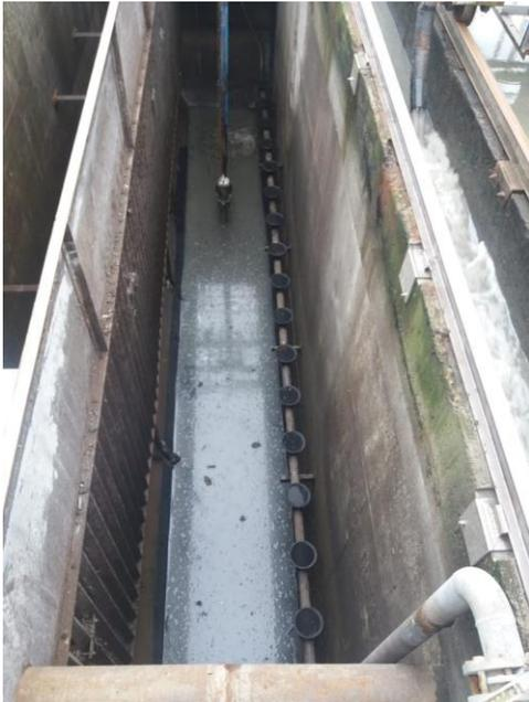
**Imagen 15.** Mantenimiento general de puentes desarenado-desengrasado pretratamiento, PTAS.
