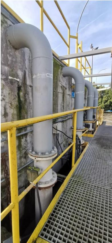
**Imagen 27.** Sensor de medición de caudal de líneas de recirculación de lodo hacia reactores biológicos, PTAS.
