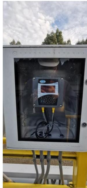
**Imagen 26.** Sensor Solidos Suspendidos Totales reactor biológico 2, PTAS Llanquihue – Puerto Varas.
