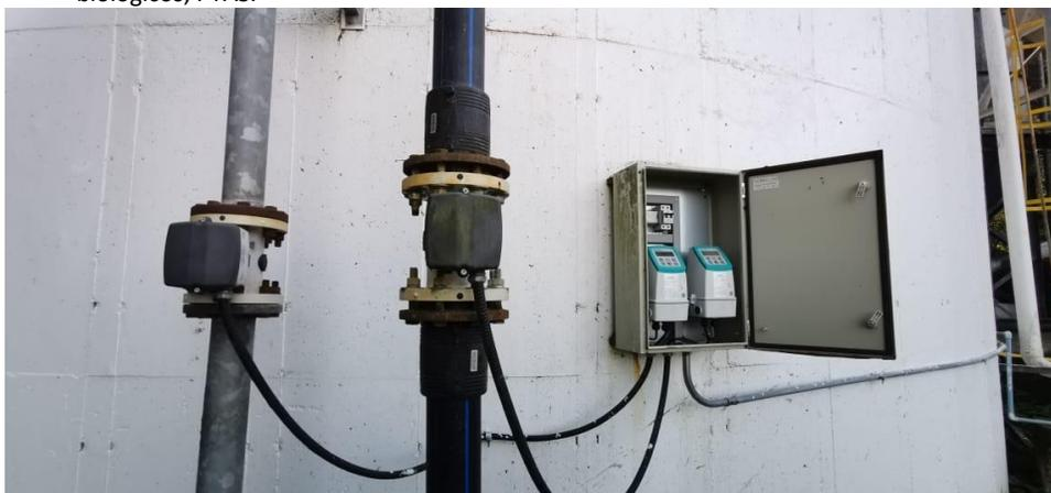
**Imagen 29.** Sensor de medición de caudal de líneas de purga de lodo en exceso, PTAS.
