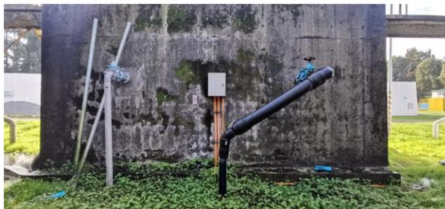
**Imagen 11.** línea de refuerzo de purga de lodos en exceso, PTAS.
