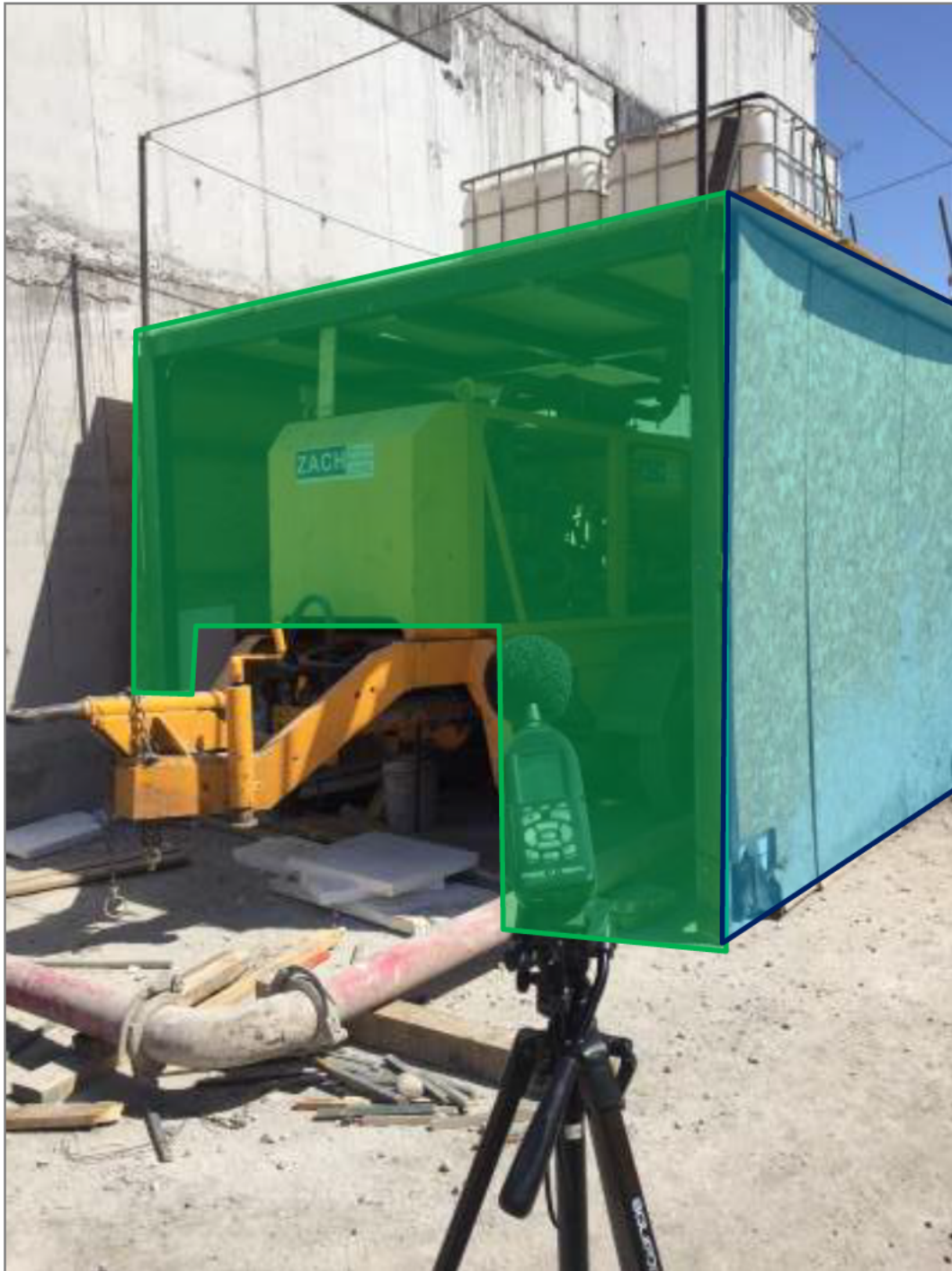
FIGURA 13. MEJORAMIENTO EN SEMIENCIERRO DE BOMBA DE HORMIGÓN.
