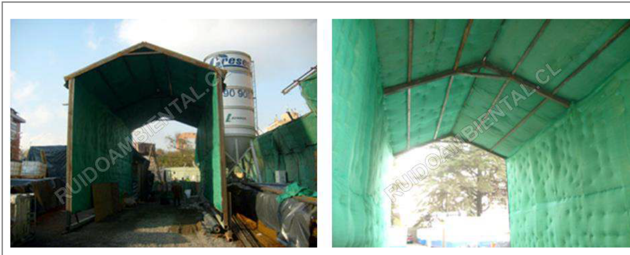
FIGURA 11. IMAGEN REFERENCIAL DE TÚNEL ACÚSTICO.
