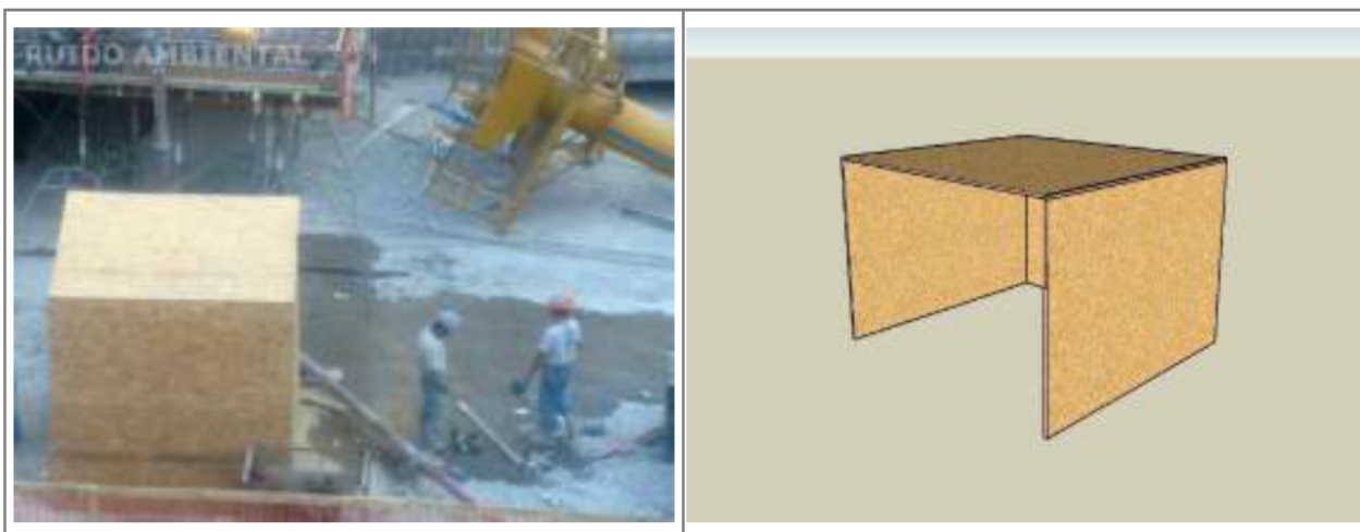
FIGURA 12. EJEMPLO SEMI ENCIERRO BOMBA DE HORMIGÓN (REFERENCIAL).
