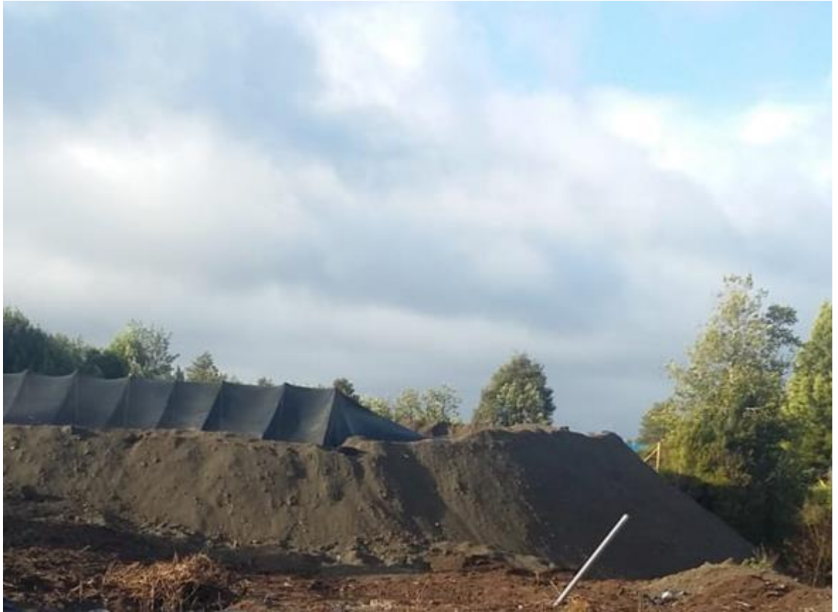
Obras de reforzamiento de talud pozo 4
