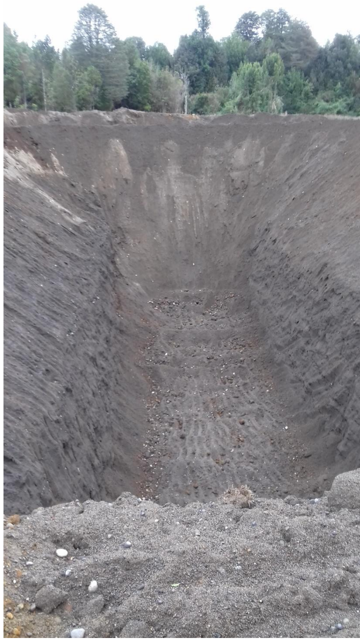
Construcción zanja pozo 4
