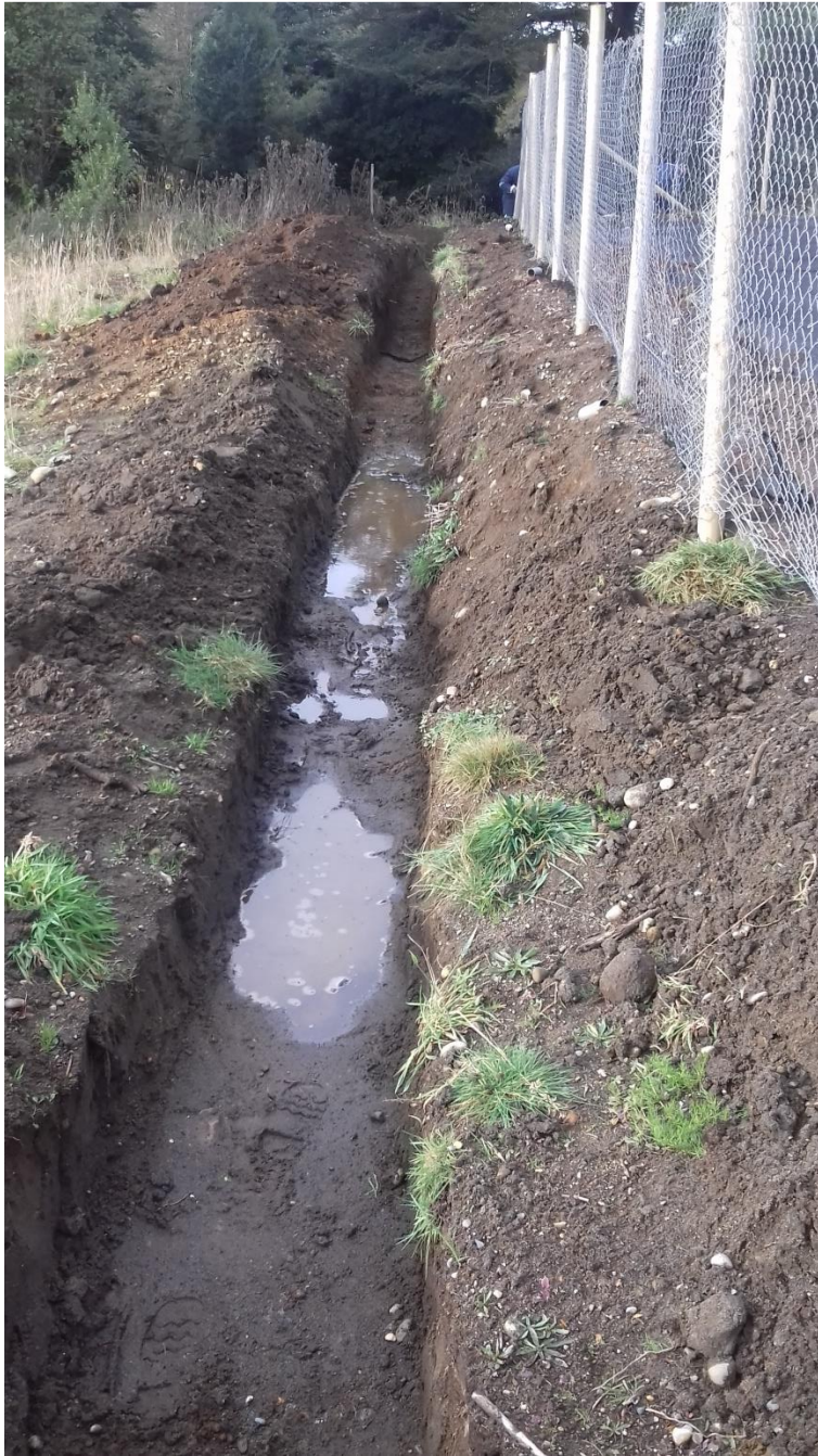
Cuneta aguas lluvias y cerco pozo 3
