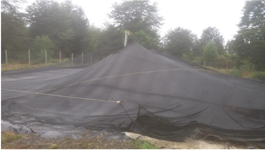
Pozo 3 durante su operación
