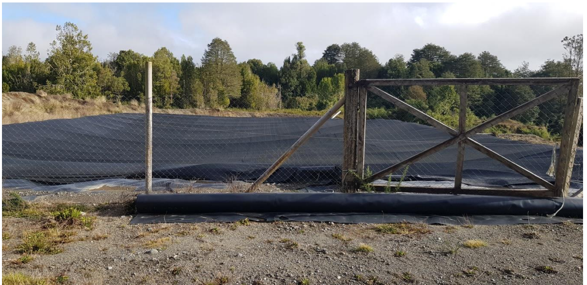
Situación actual pozo 4
