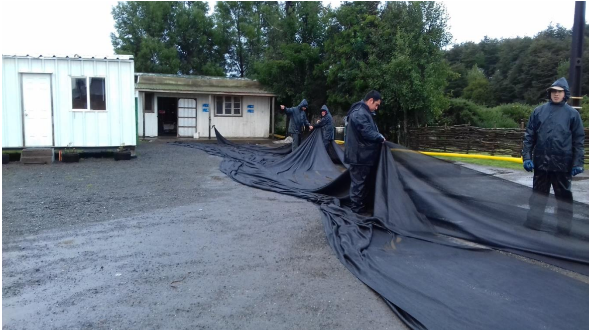
Construcción techo pozo 4
