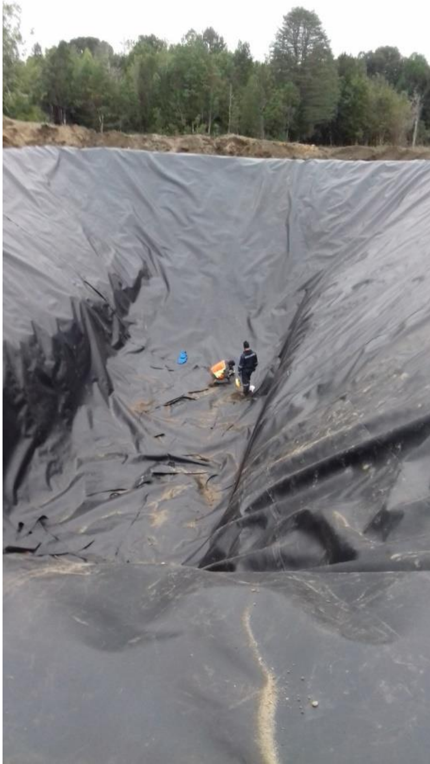
Impermeabilización pozo 4
