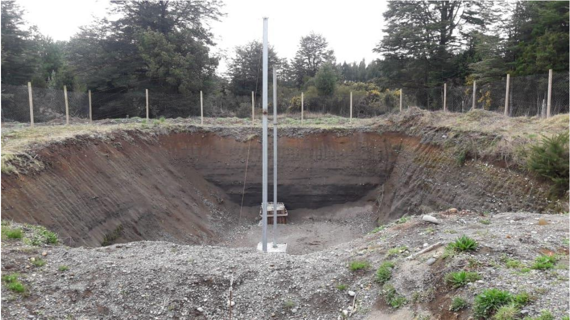
Pozo 3 instalación perfiles y muertos para techo
