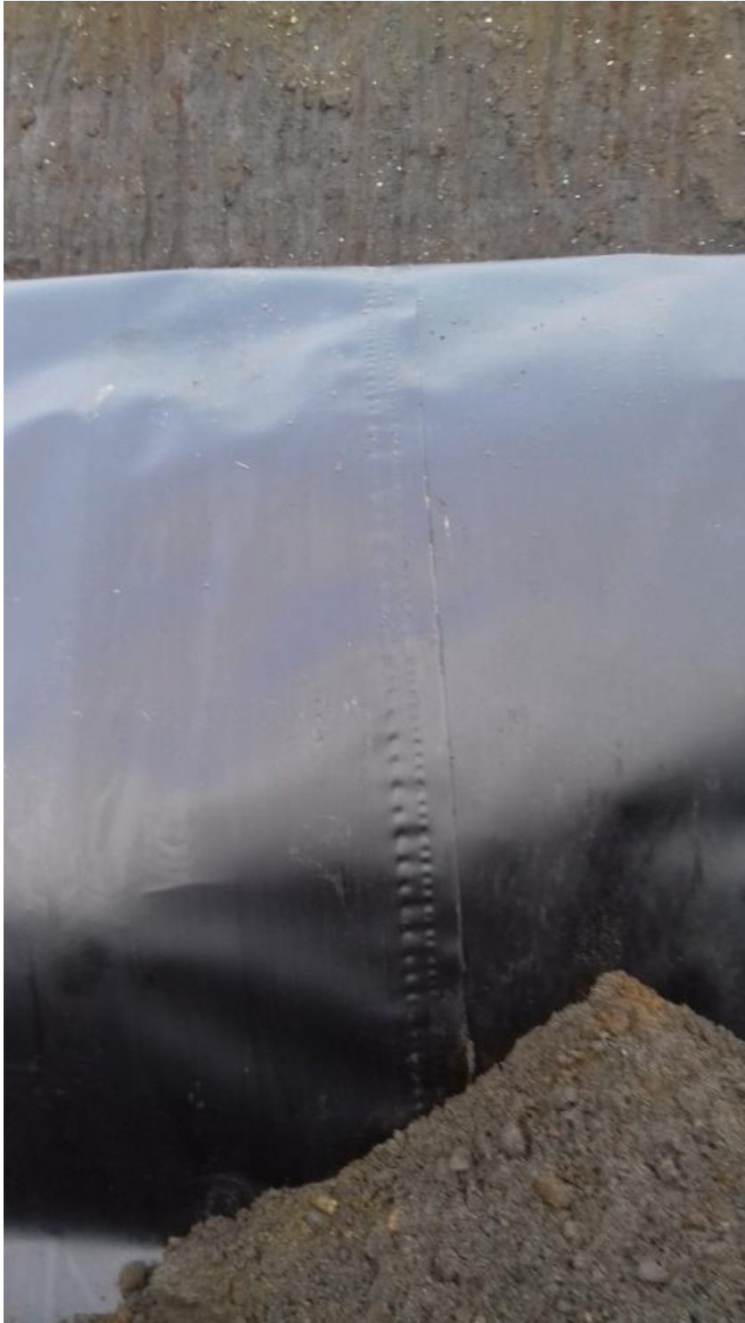
Termofusión geomembrana pozo 4
