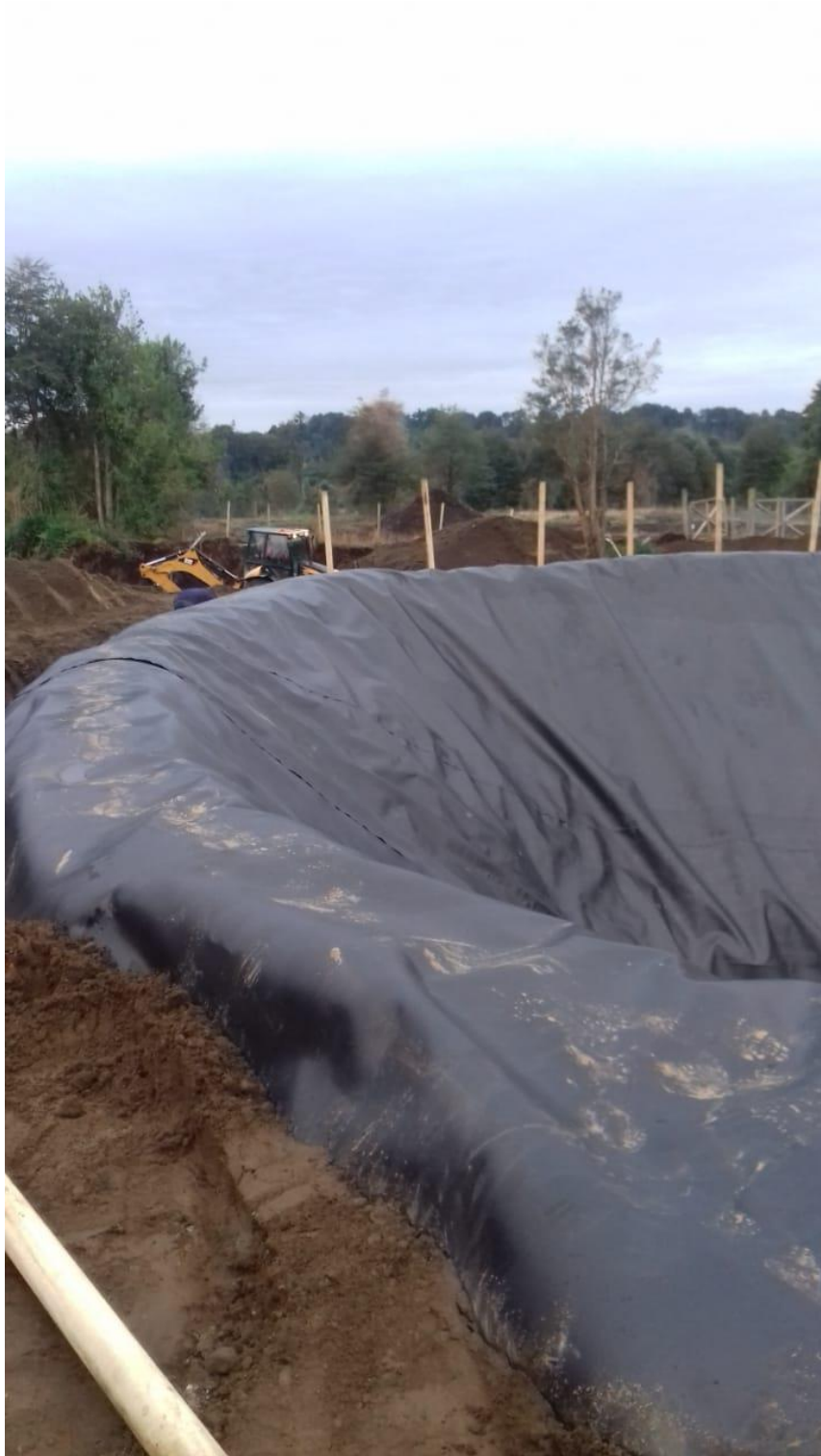
Anclaje de geomembrana pozo 4
