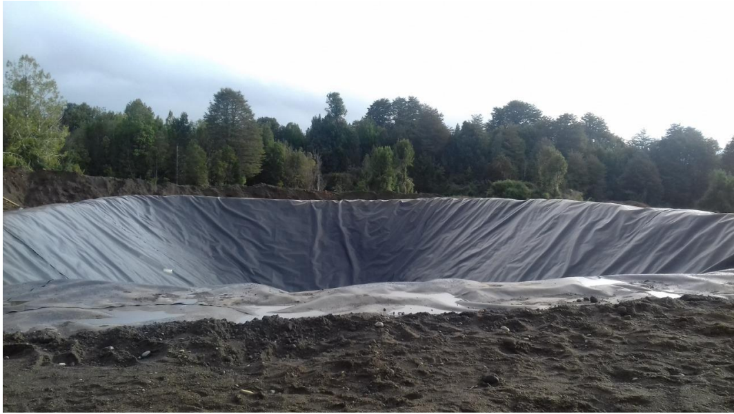
Pozo 4 impermeabilizado
