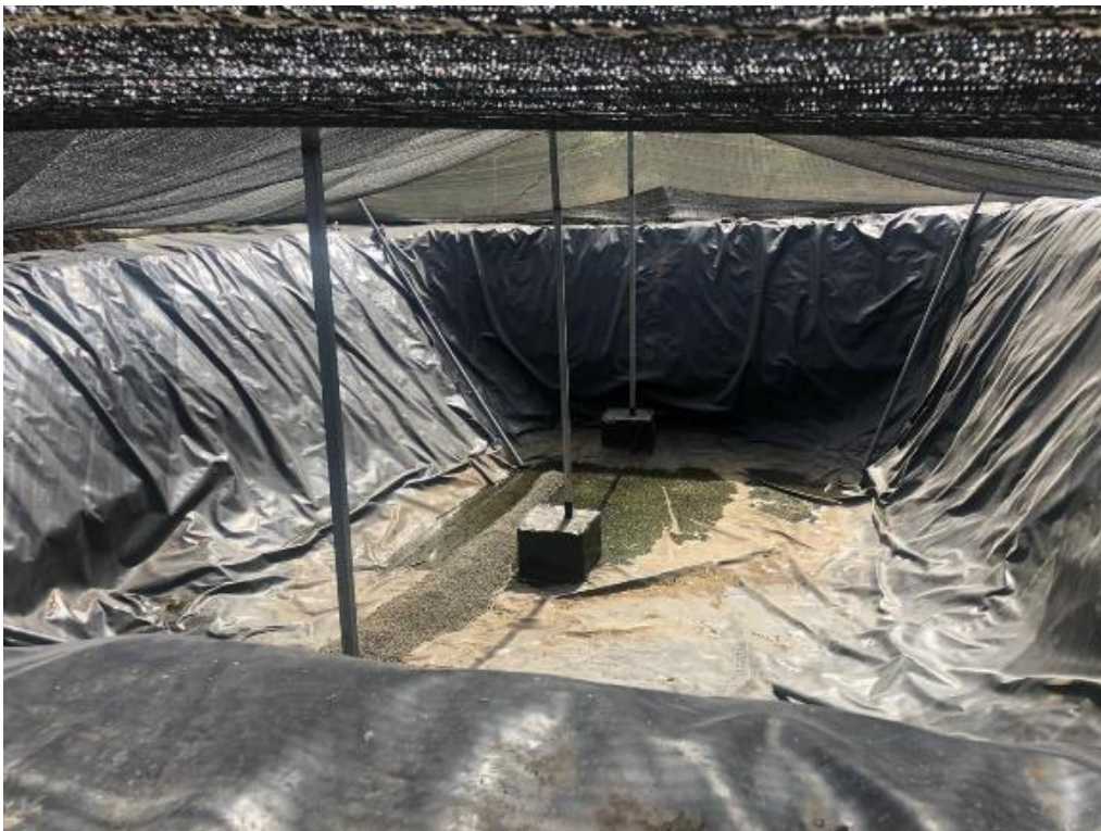
Pozo 3 impermeabilización completa, techo y canal recogida de lixiviados
