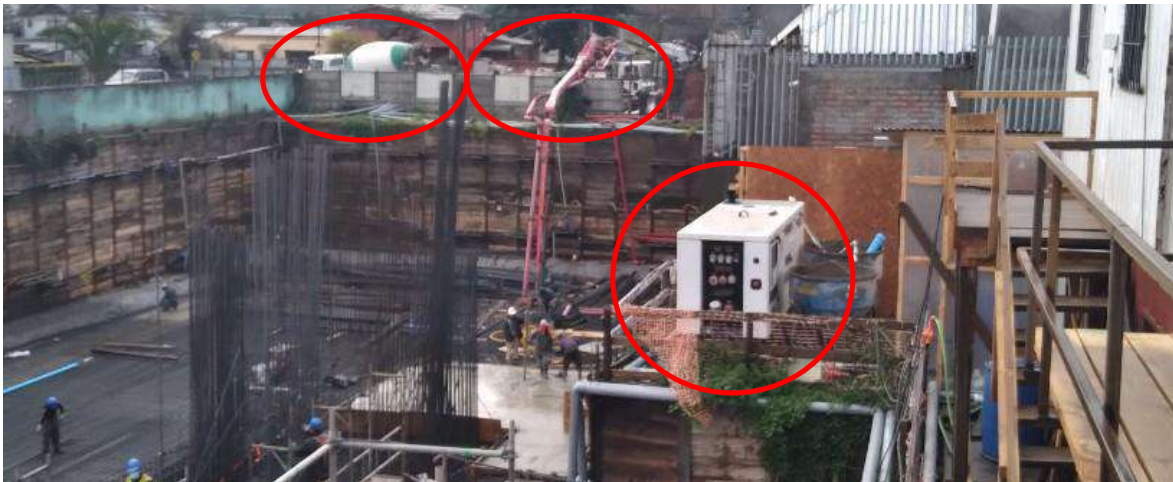
Fotografía 1: En círculos se aprecia mixer y pluma hormigonera. Además se ve el generador eléctrico que provee energía eléctrica a la Obra..
