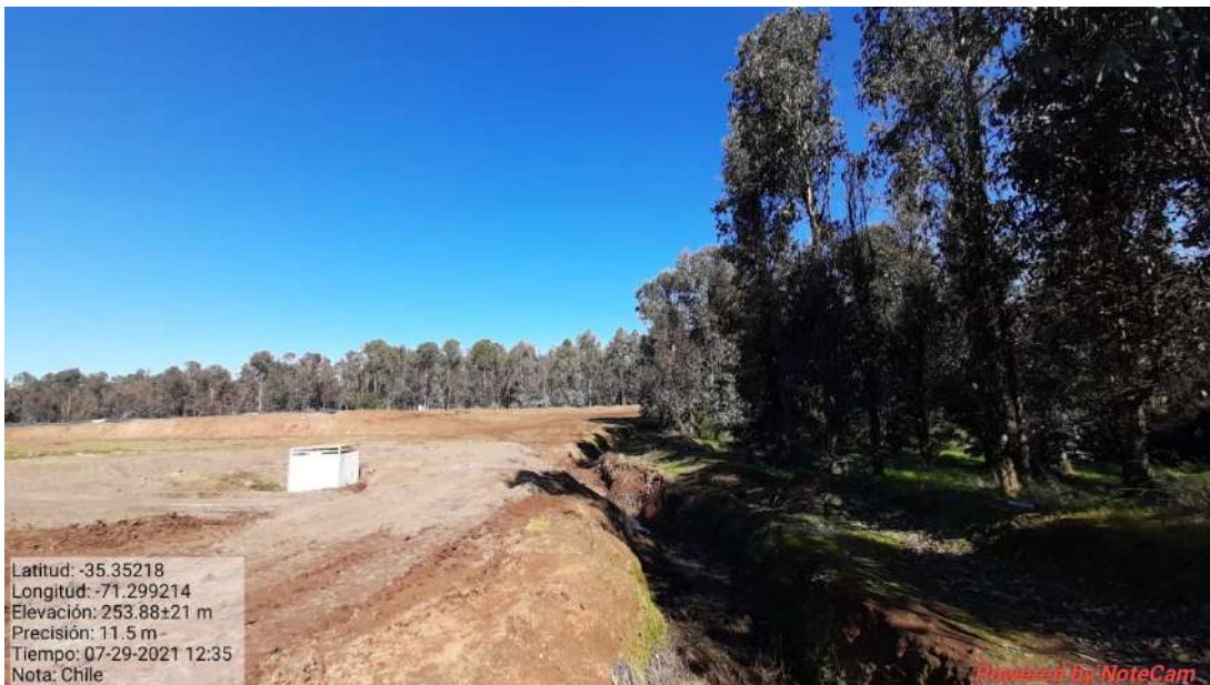
Figura 11. Canal perimetral del proyecto, sector menor cota.
