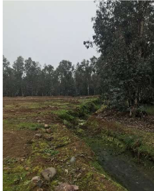
Figura 13. Canal perimetral exterior
