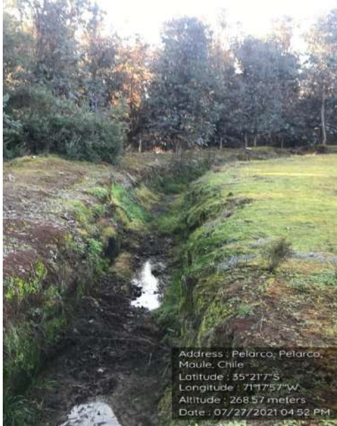
Figura 12. Canal perimetral exterior
