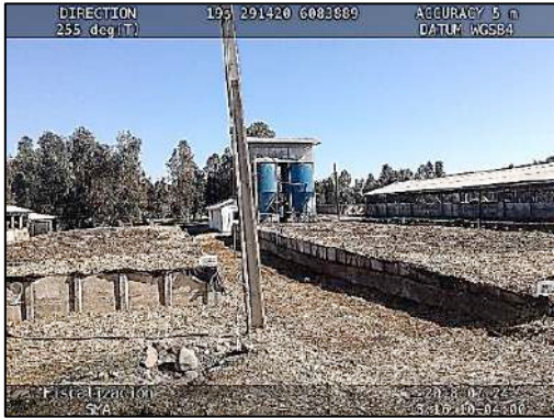
Figura 6. Módulos lombrifiltro sin techar y sin malla raschel de protección lateral en Sitio 2
