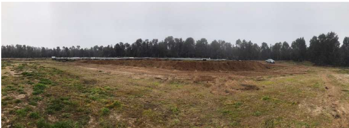
Figura 9. Vista panorámica peraltamiento cuadrante 2 y uso de sistema de cobertura
