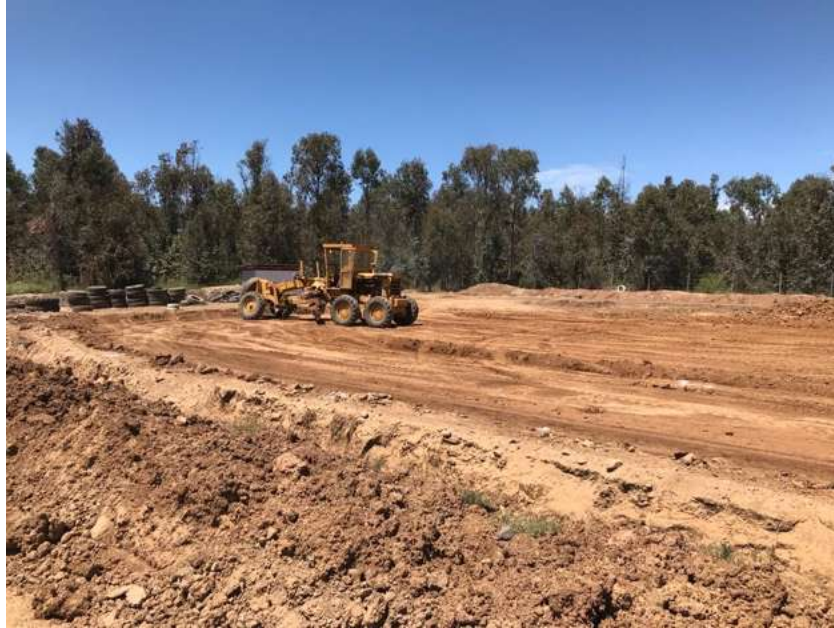
Figura 7. Obras de nivelación y construcción de peraltamiento y canales de contorno
