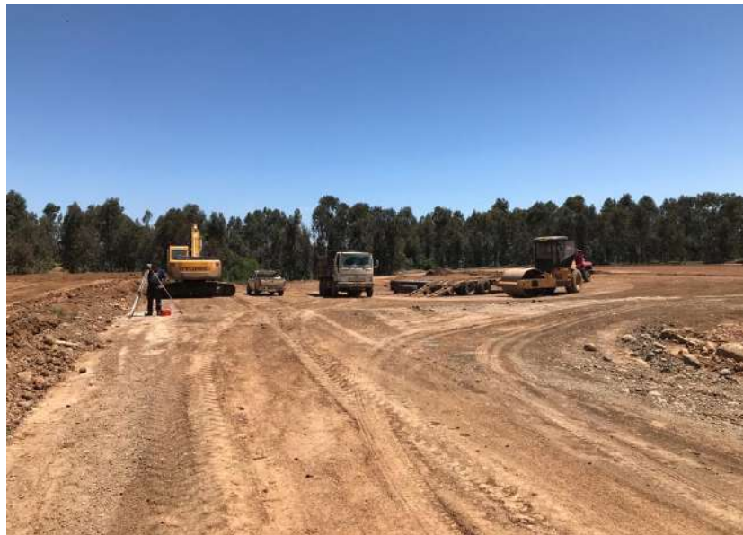
Figura 6. Obras de nivelación y construcción de peraltamiento y canales de contorno
