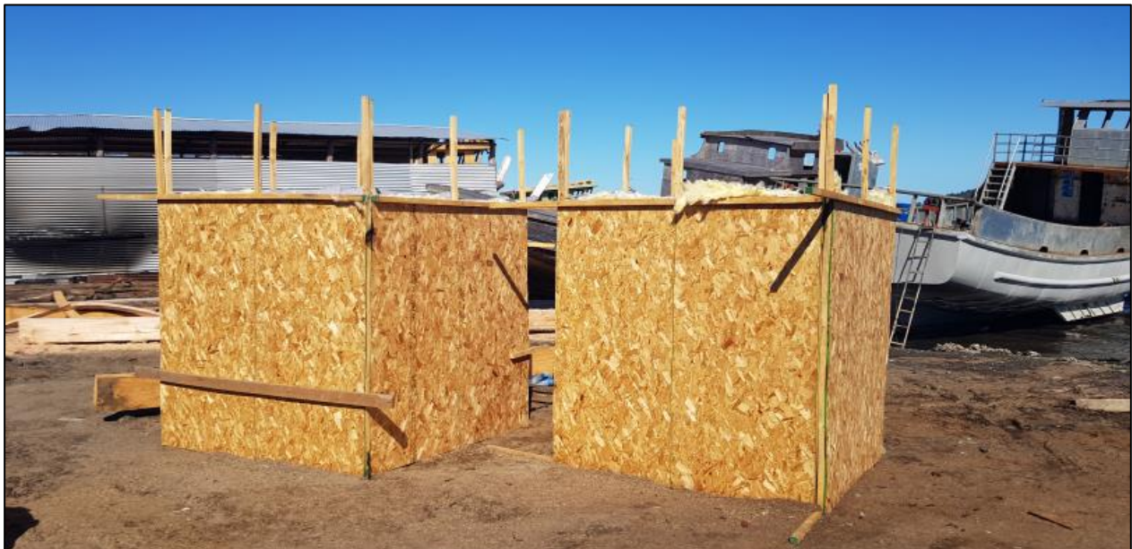
Ilustración 16. Fotografía de barreras acústicas móviles ya implementadas en el Astillero vista 2
