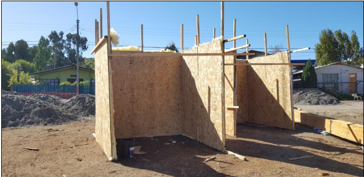
Ilustración 15. Fotografía de barreras acústicas móviles ya implementadas en el Astillero vista 1
