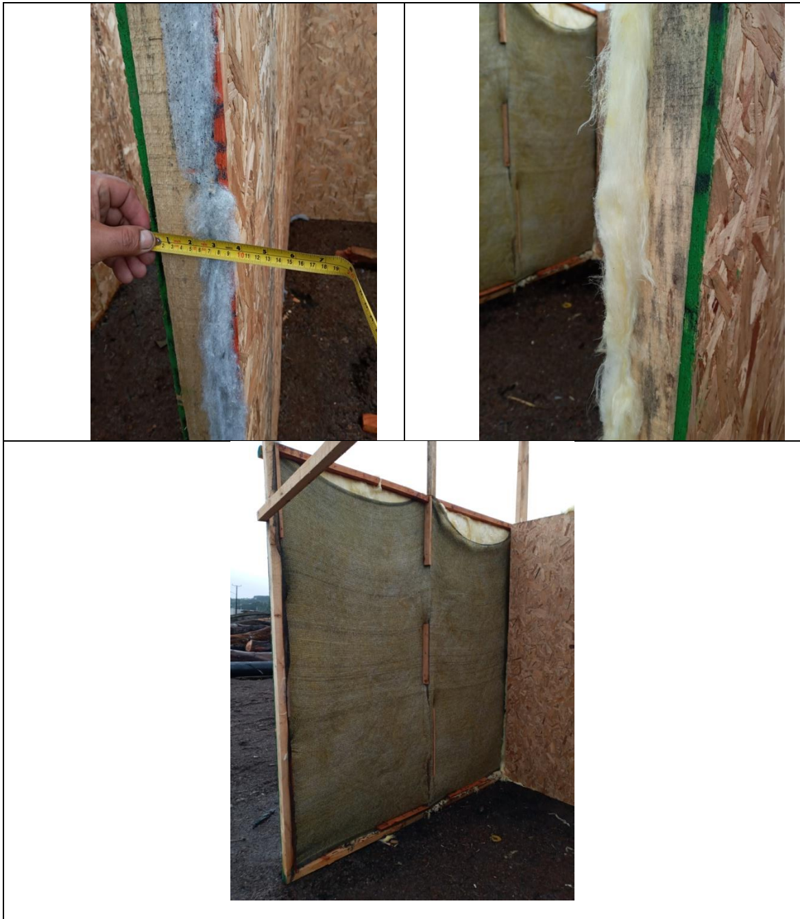
Materialidad de Biombo: Plancha de osb de 15mm, aislante poliéster 55mm, Lana de vidrio 40mm (se adjunta factura de compra 110079518.)
