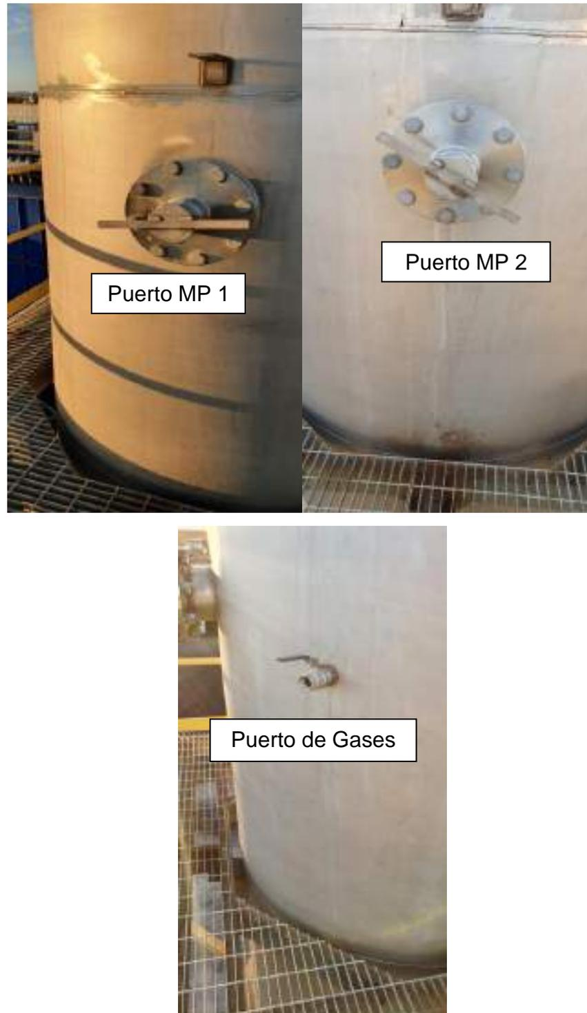
**Figura N°3: Puertos de MP y Gases**
