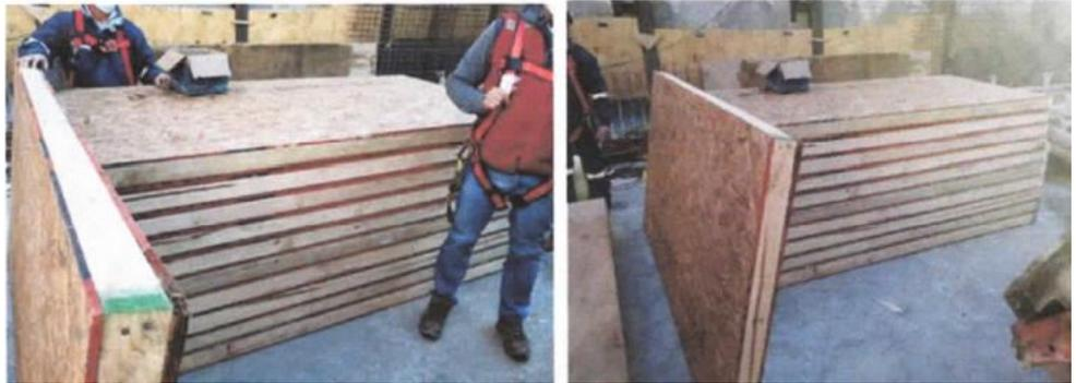
Generadores protegidos y aislados con paneles de madera y material absorbente acústico
