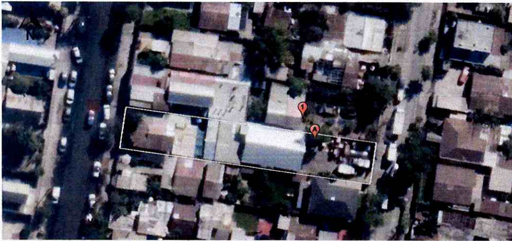
Figura 1: Imagen satelital del sector donde se presenta el predio de la unidad fiscalizable indicado con un rectángulo blanco, ubicación de los ventiladores de cámaras de frío identificado con la letra A y la ubicación del receptor sensible fiscalizado con el número 1.
