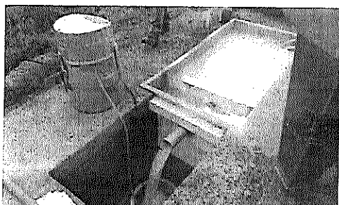
Fotografia 1: Instalacion Equipo Automático
