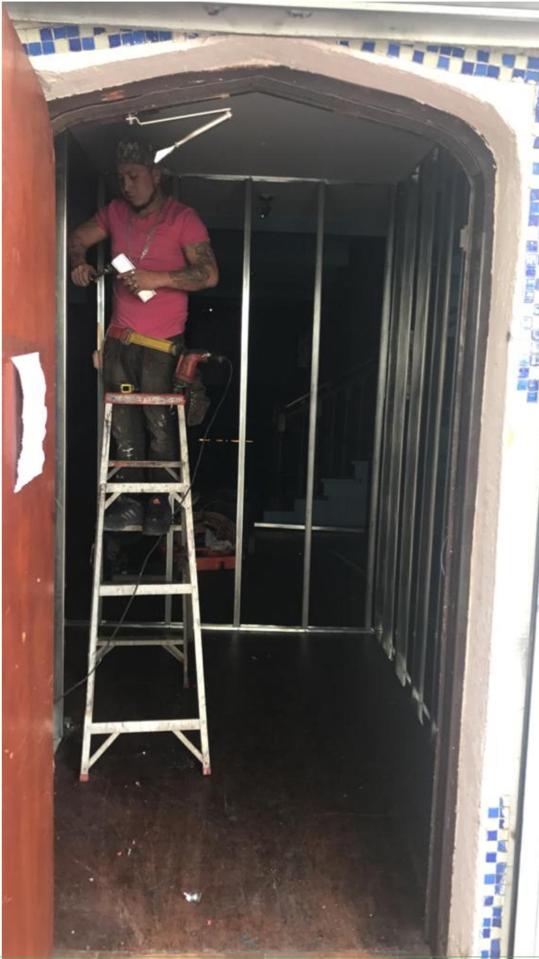
Figura 7: Fotografía de la construcción de soluciones para la mitigación del ruido.
