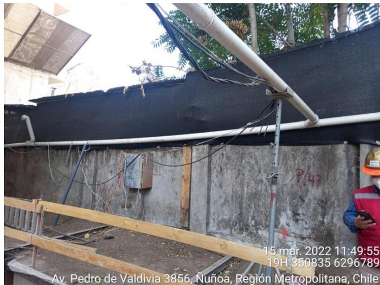
Se deberá instalar planchas OSB 15 mm, material aislante aislanglass (lana mineral) de 40 mm de espesor, y recubierto de malla raschel para evitar su deterioro y/o desprendimiento.
