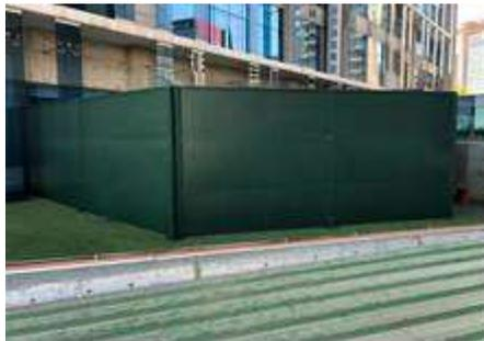
**Fotografía 3:** Se observa pantalla acústica rodeando los equipos.
