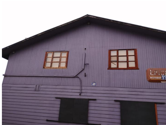
Cambio de ventanas termopaneles según presupuesto adjunto
