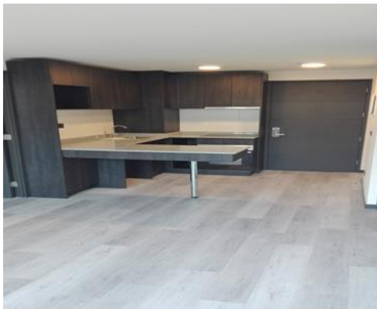
Fotografía pisos 7 y 8: trabajos de instalación de muebles, closets y piso vinílico
