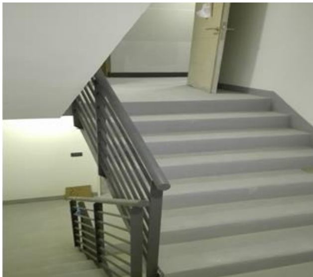
Escaleras: trabajos de pintura
