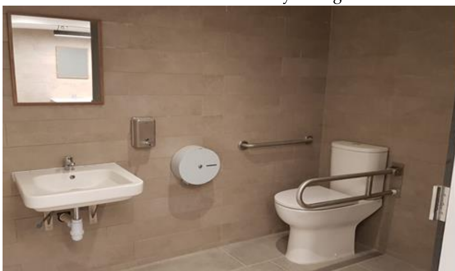
Baño para discapacitados: terminado
