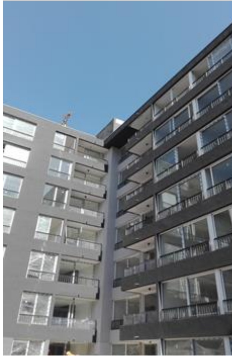
Fotografía 2 (Fachada Interior patio norte piso 1 y 2): Terminado
