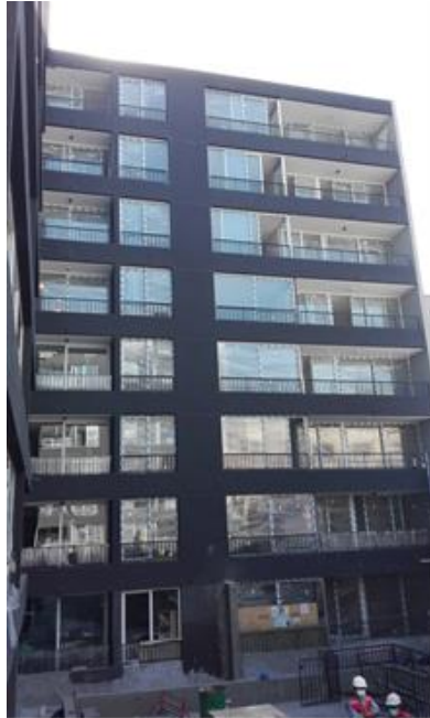
Fotografía 4 (Fachada Interior patio note): Trabajos de pintura piso 1
