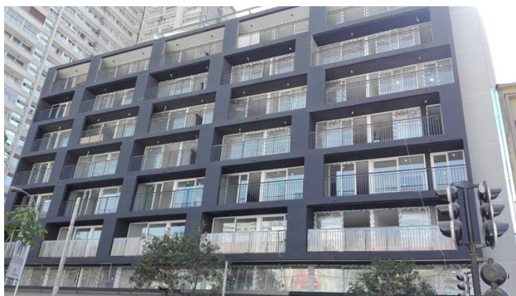
Fotografía 1 (Fachada San Diego): Se realizan trabajos de reparación y levantamiento de observaciones de pintura en terrazas
