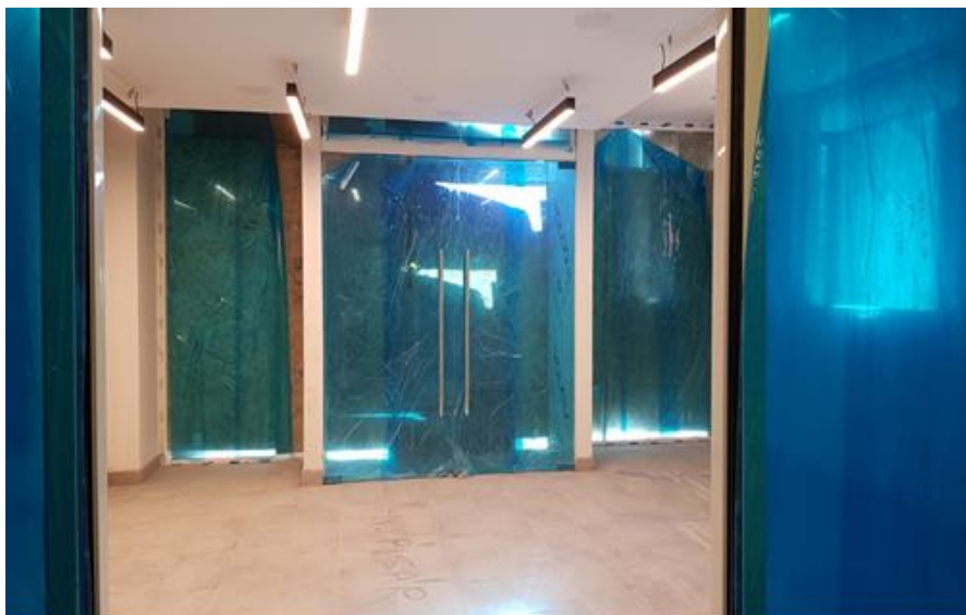
Acceso a obra: remates y entrega
