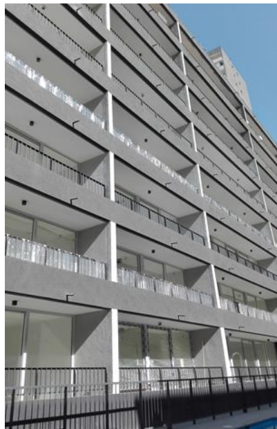
Fotografía 3 (Fachada Interior patio poniente): Terminado
