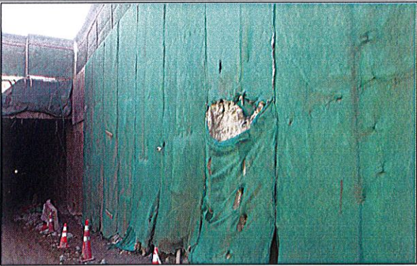
Fotografía 1 Cara interior paneles poniente rampa Cuenca, en mal estado al 27.05.2021
