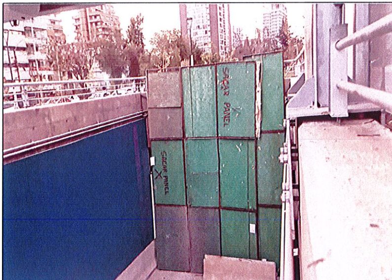
Fotografía 10 Cara externa cierre acústico en boca del túnel Cuenca.
