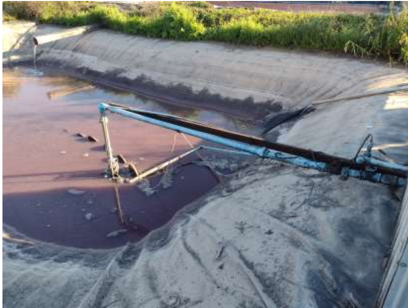
Imagen N° 6 – Pozo Acumulación de RILes (Pozo 1)
