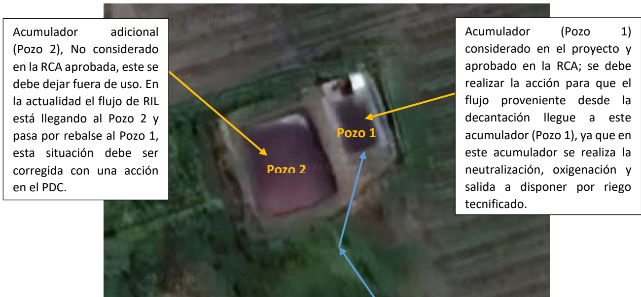
Imagen N° 5 – Zona Pozo de Acumulación
