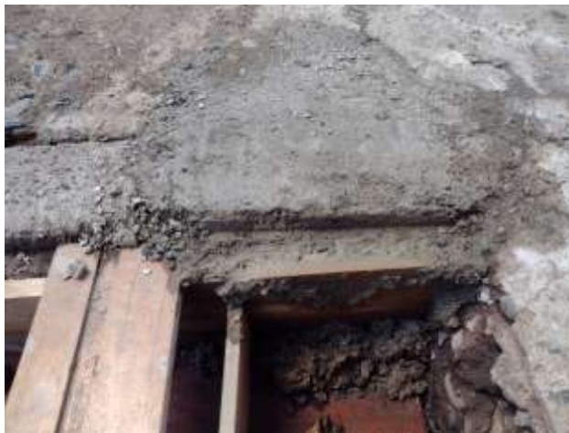
Imagen N°1 – Tapado Canaleta con Hormigón
