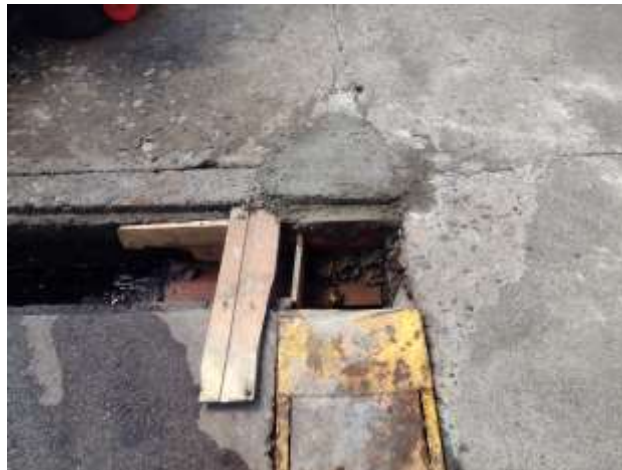
Imagen N°1 – Tapado Canaleta con Hormigón
