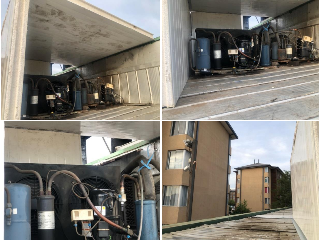
Figura 4: Situación actual de la fuente emisora.
