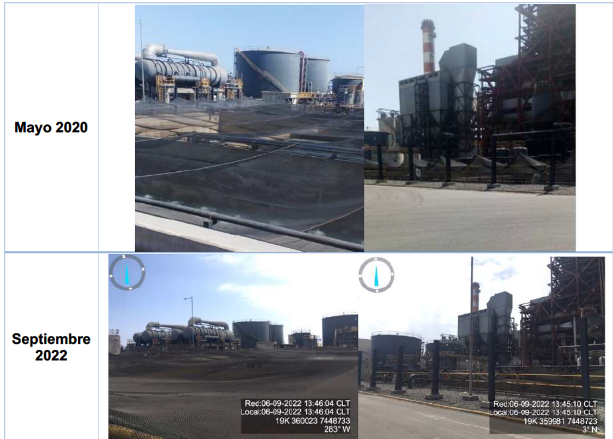
Figura 3: Fotografías de mallas instaladas en piscinas de sedimentación y neutralización
