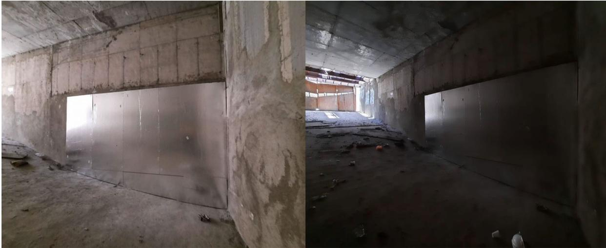
Figura 3: Medio de Verificación Tabique Acústico.
