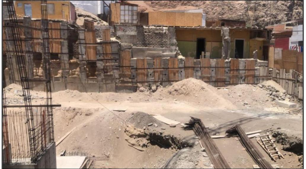
Situación actual donde se aprecian los dos anclajes por el deslinde Este y el resto por el deslinde Sur. Además, se aprecia la ejecución de los muros de contención de las dos laderas vecinas (Este y Sur) sin riesgo de caída, desplazamiento y/o derrumbes de propiedades vecinas. La obra se encuentra actualmente paralizada por falta de financiamiento bancario.
