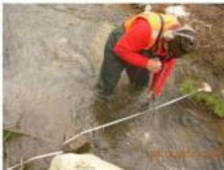
Figura N°3: Ejecución de aforo, por video del escurrimiento de agua.
