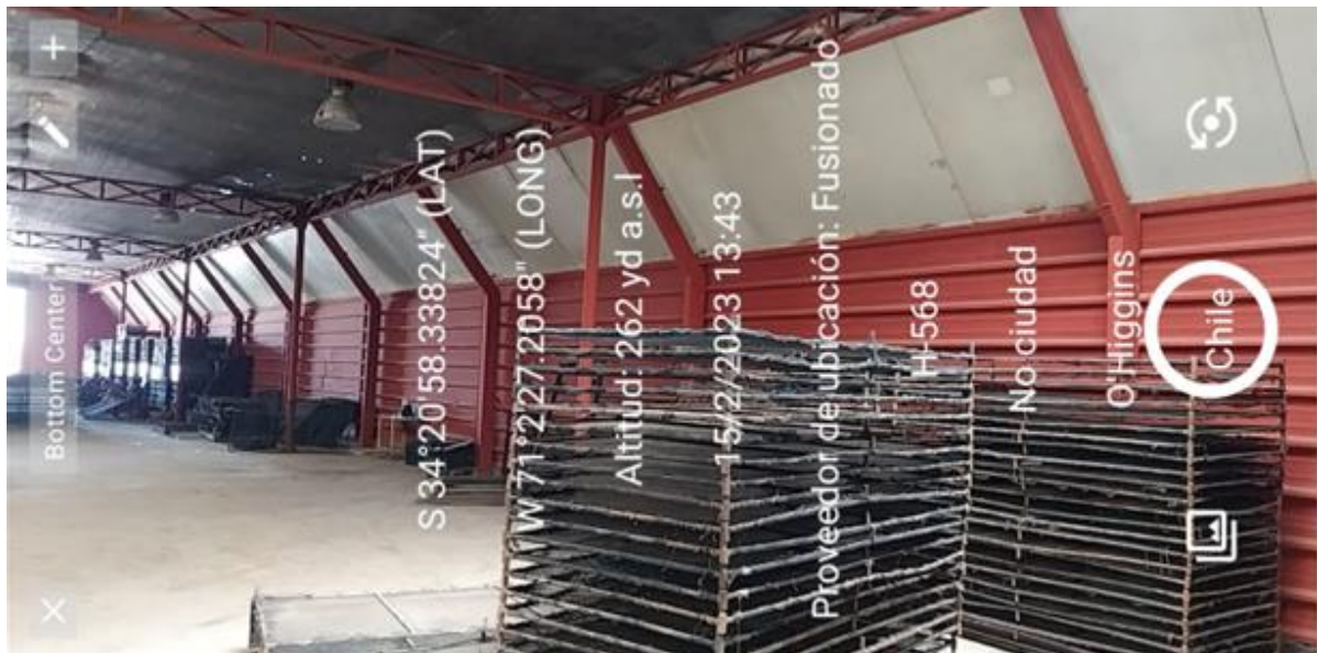
Figura 1. Sector de la planta cerrado con aislante acústico
