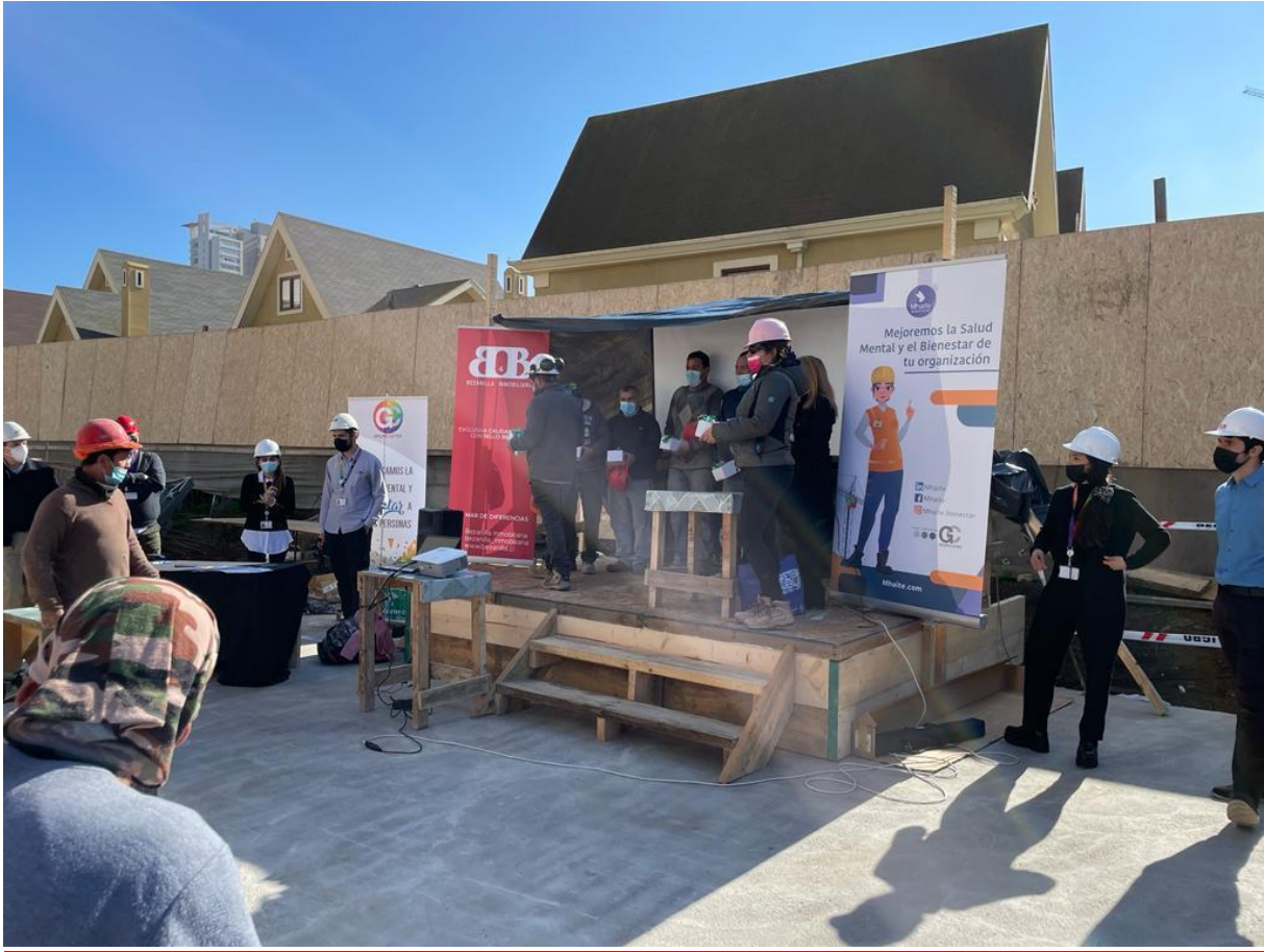
Foto barrera OSB durante obra gruesa
