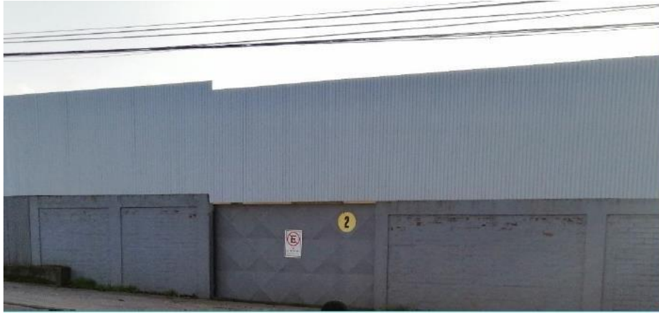
Fotografía implementación barrera acústica, cierre perimetral oriente
