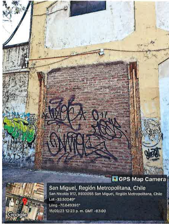
Ilustración 22. Muro área de mantención
