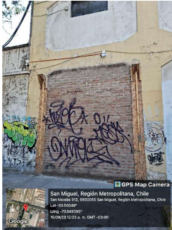
Ilustración 15. Muro sólido área mantención
