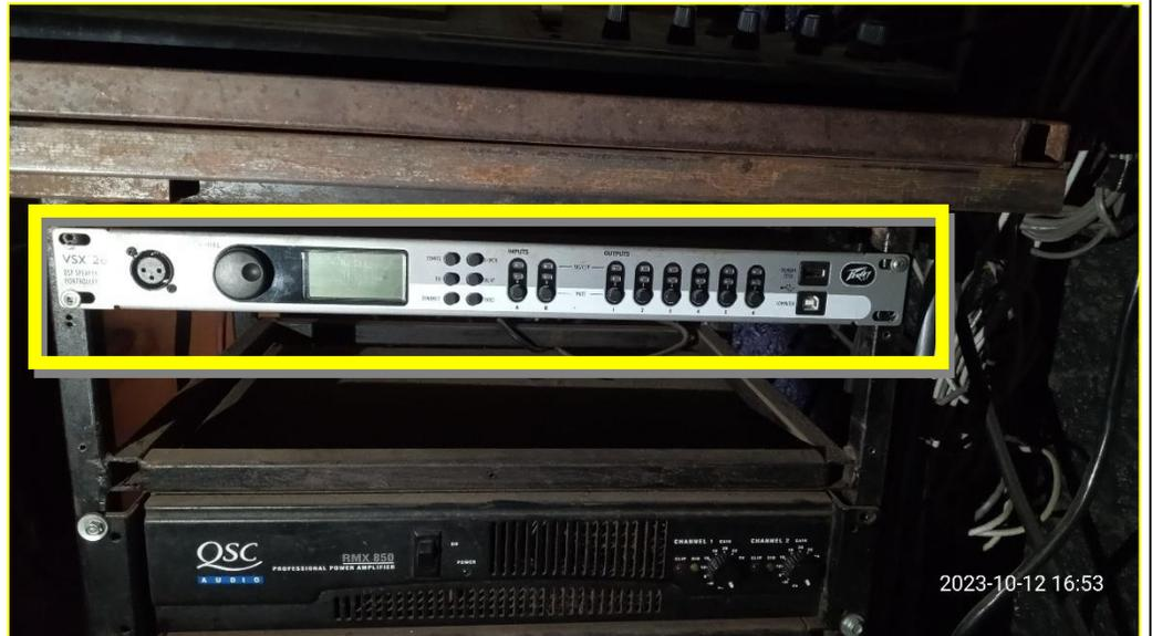
Imagen 6, Implementación Limitador Acústico en sala principal
