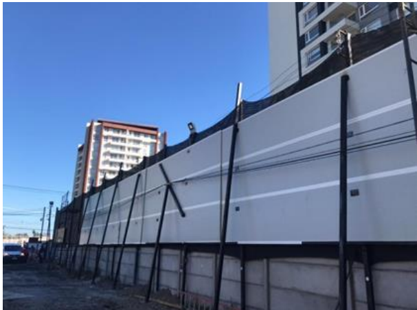
Imagen 4 Instalación Paneles TK100
