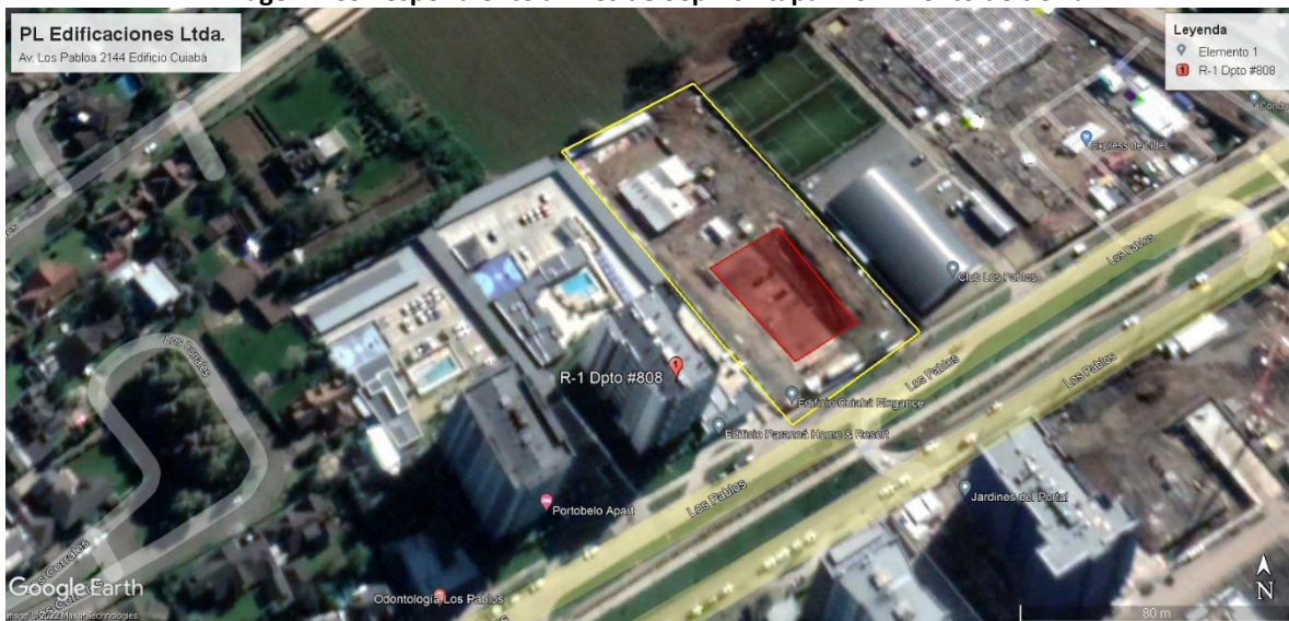
Imagen 1 Correspondiente al mes de Sep-20 Etapa Movimiento de tierra
