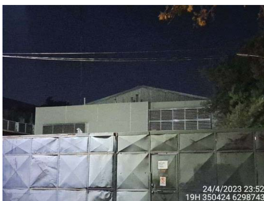
Ubicación de equipos de aire de la Unidad Inspeccionada
