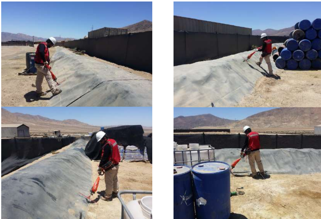
FOTOGRAFIAS DE ENSAYO ARC TESTING BAJO NORMA ASTM D-7953 EN CANCHA DE ACOPIO
