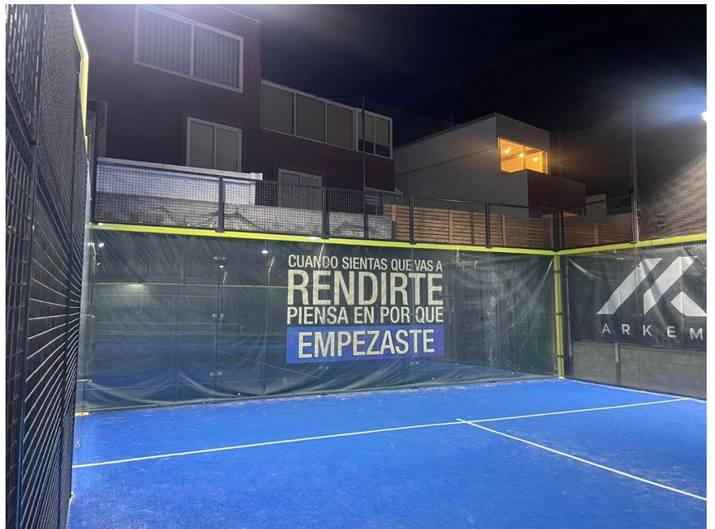
Fotografía sector de implementación barrera acústica cancha 2.
