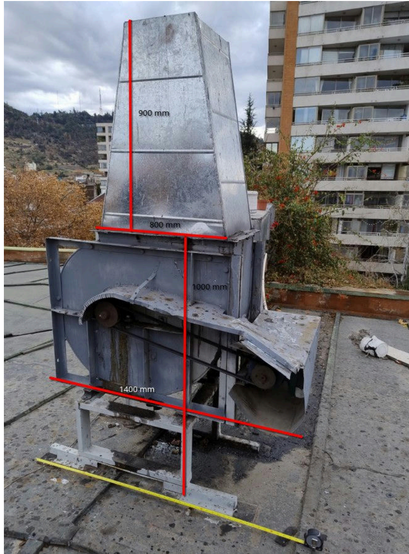
Figura 1: Dimensiones de referencia del sistema de extracción del local “La Antojería” que actúa como fuente de ruido.
