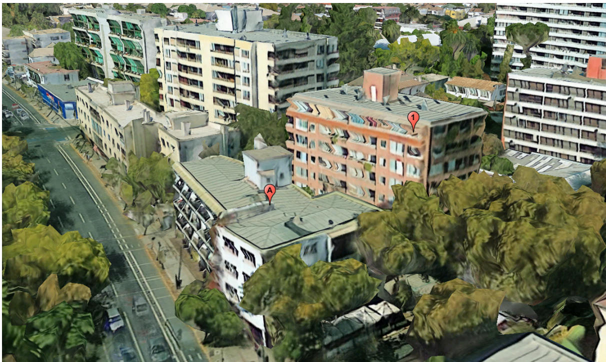
Figura 3: Vista tridimensional referencial de la ubicación de fuentes de ruido del sistema de extracción del local “La Antojería”. La letra “A” representa la ubicación de la fuente de ruido del sistema de extracción de aire, y el número “1” es la ubicación del receptor afectado.
