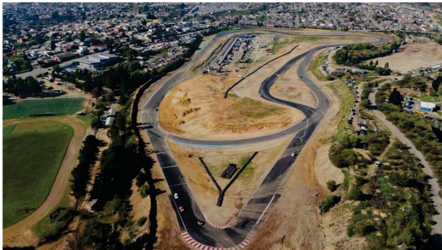
Figura N° 5: Vista aérea de curvas ubicadas hacia el poniente del Autódromo
