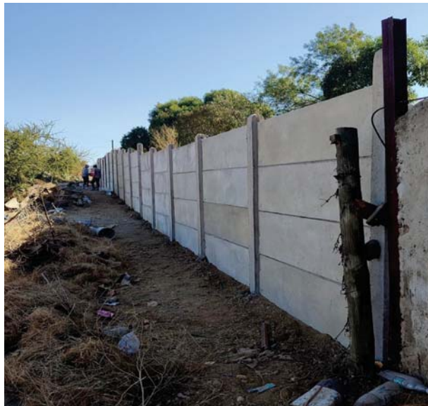
Figura N° 11. Nuevo cierre perimetral del sector oriente
