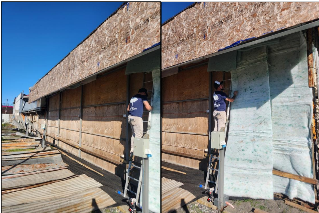
Mejoramiento del índice de reducción de ruido en pared derecha
