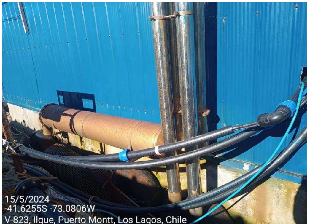
Después exterior, trabajo silenciador línea 2
