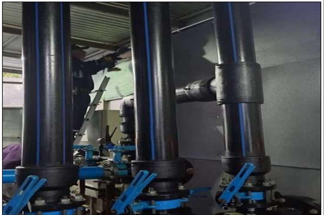
Trabajo 1 después, interior encierro acústico sala de bombas planta B:
