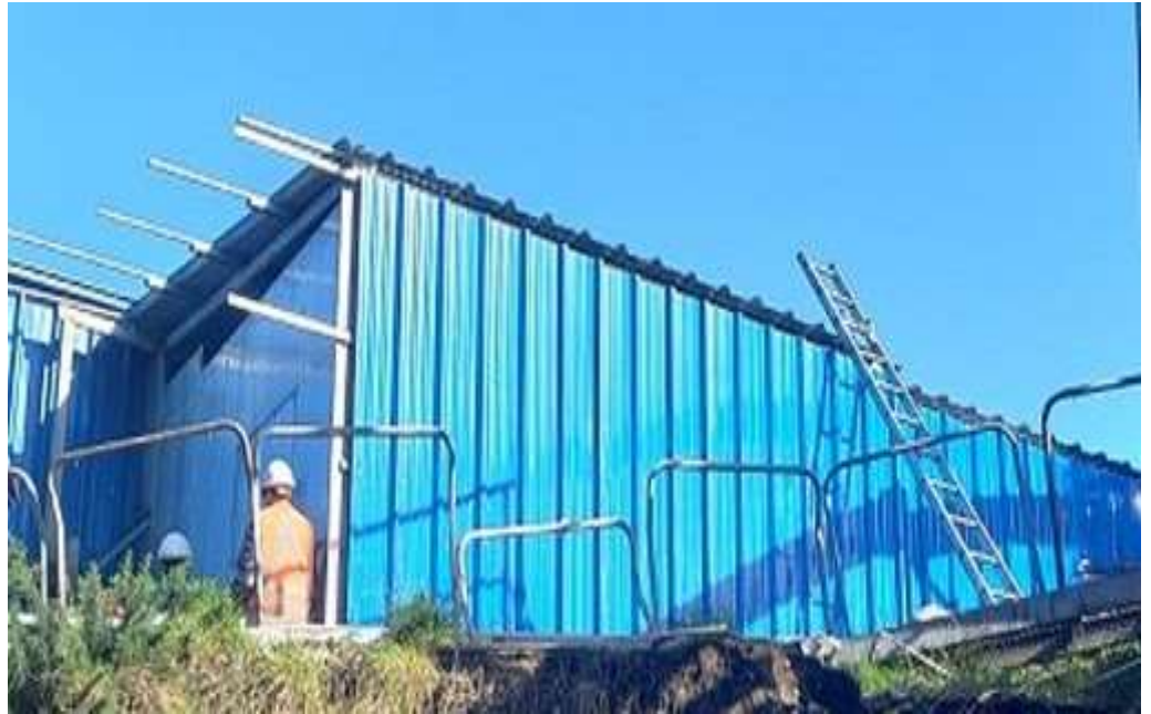
Trabajo 1 después, exterior encierro acústico sala de bombas planta B:
