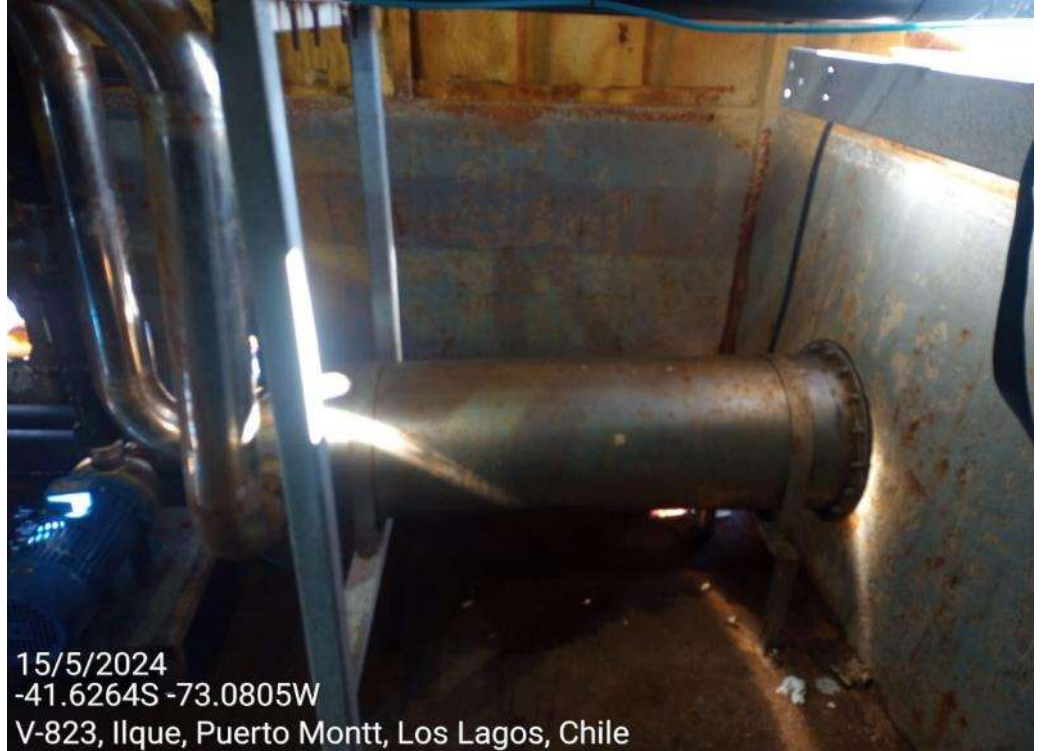
Después exterior, trabajo silenciador línea 4
