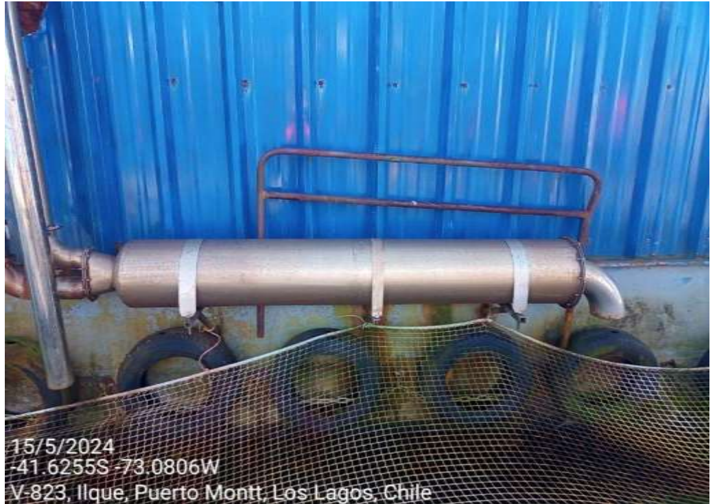
Después exterior, trabajo silenciador línea 2
