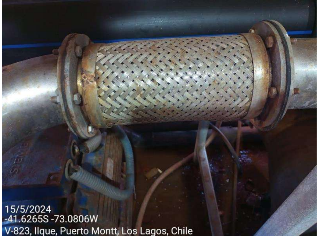
Después interior, trabajos silenciadores bomba líneas 1, 2, 3 y 4
