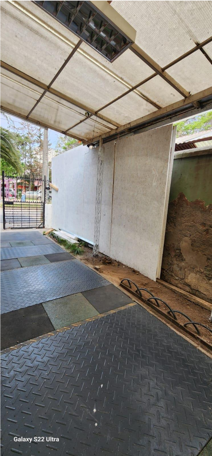
DURANTE TRABAJOS OCTUBRE DE 2023.
