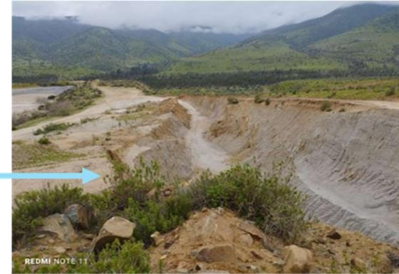
Adicionalmente a lo incluido en DIA sección 3.5 la demas aguas que se pudieran generar son conducidas a un resumidero (generado a partir de las excavaciones para extracción de material utilizado para la construcción de las etapas I, II y III del embalse las Vas Sur) ubicado a 40 m al sur del depósito de relaves Las Vacas III y que cuentan con capacidad de almacenamiento de aprox. 12.000 m<sup>3</sup>. (área media de 3.000 m<sup>2</sup> x aprox. 4 m de altura)
